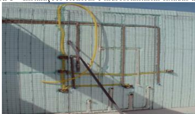
Figura 8 – Instalações elétricas e hidrossanitárias fixadas à malha
