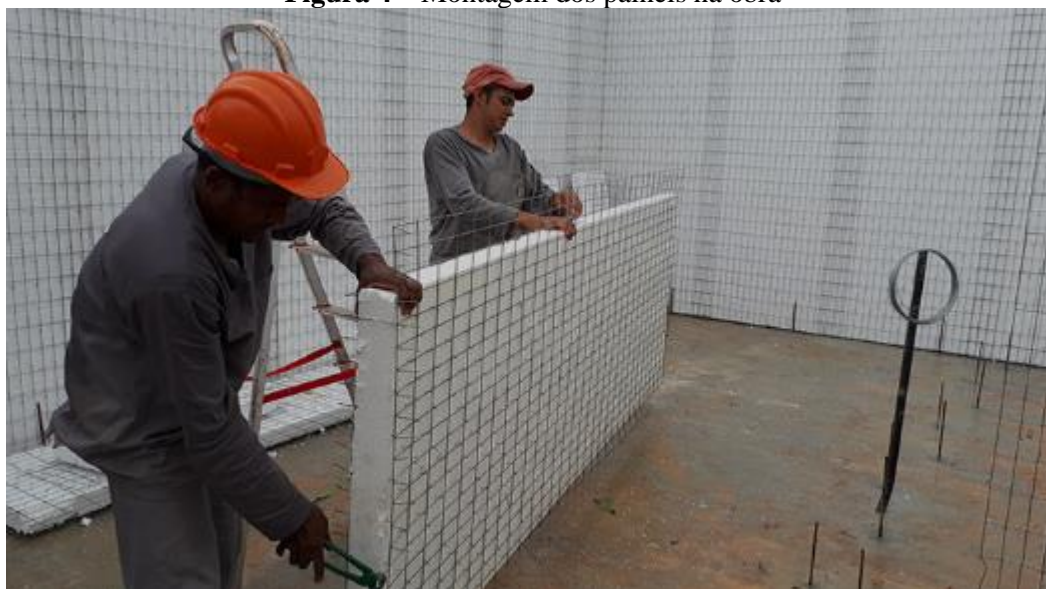
Figura 4 – Montagem dos painéis na obra
