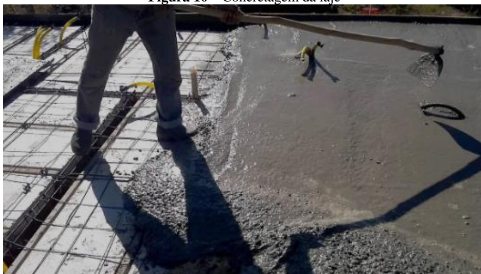
Figura 10 – Concretagem da laje
