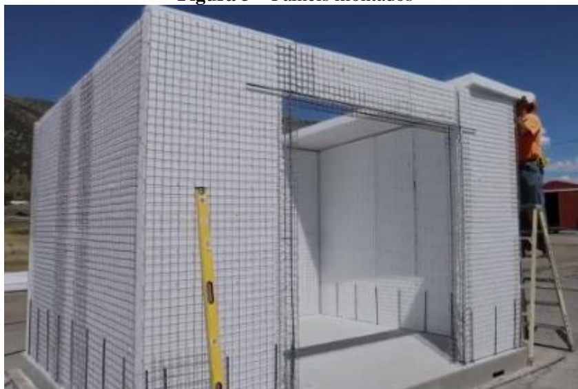
Figura 5 – Painéis montados
