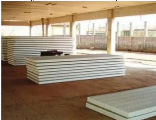
Figura 2 – Armazenamento dos painéis
