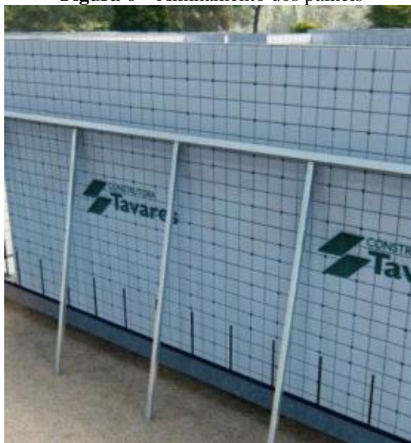
Figura 6 – Alinhamento dos painéis
