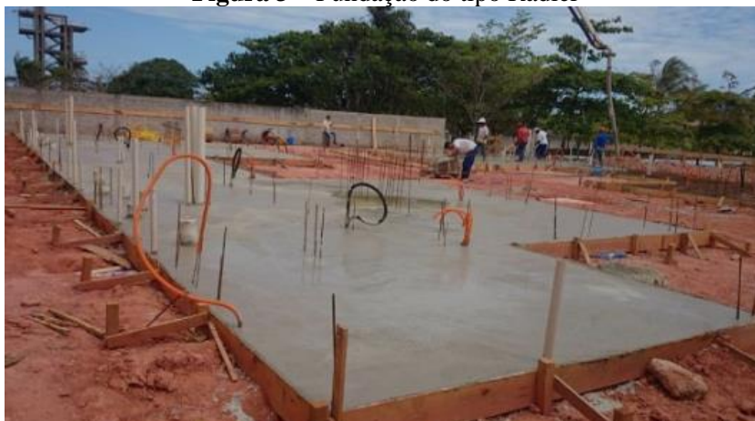
Figura 3 – Fundação do tipo Radier
