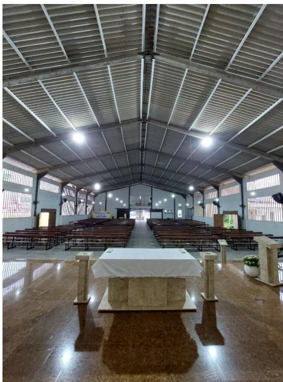
Figura 8- Interior da igreja após a conclusão da reforma.
