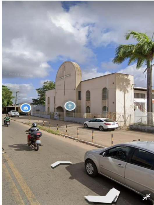
Figura 6 - Apresentação do local da obra.
