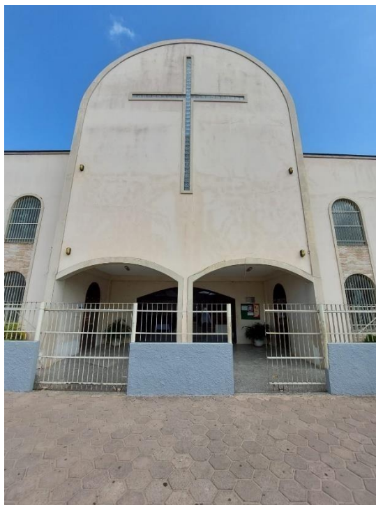
Figura 7 – Fachada da igreja.
