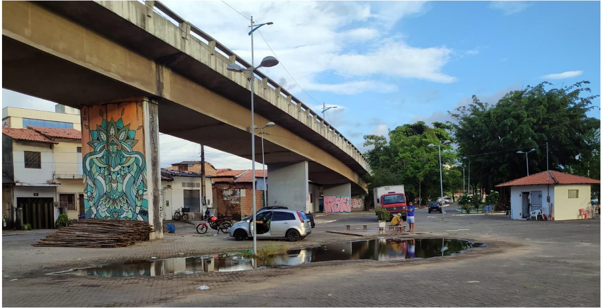
Figura 18: Fotografia da poça d'água na Praça Maria Firmina
