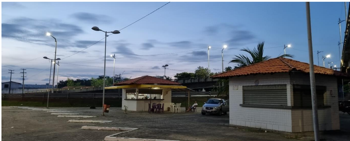
Figura 16: Fotografia dos postes na Praça Maria Firmina
