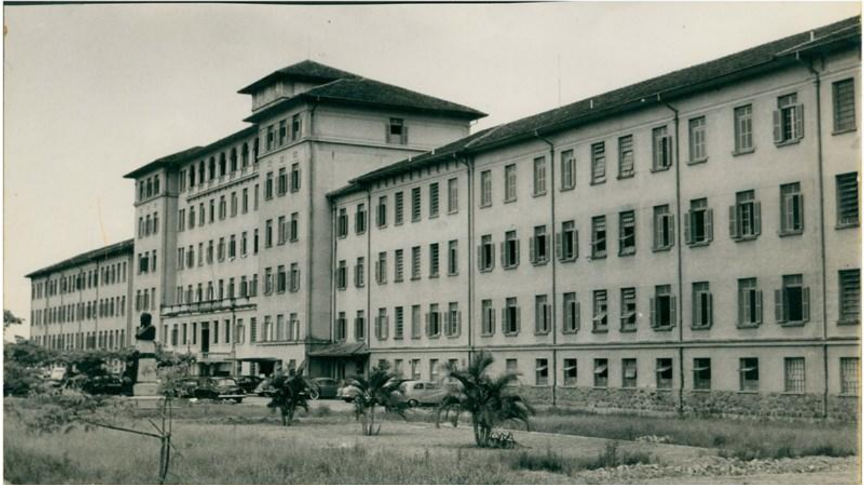
FIG 23 – Vista Externa do Hospital Santa Cruz da Misericórdia de Santos - SP.
