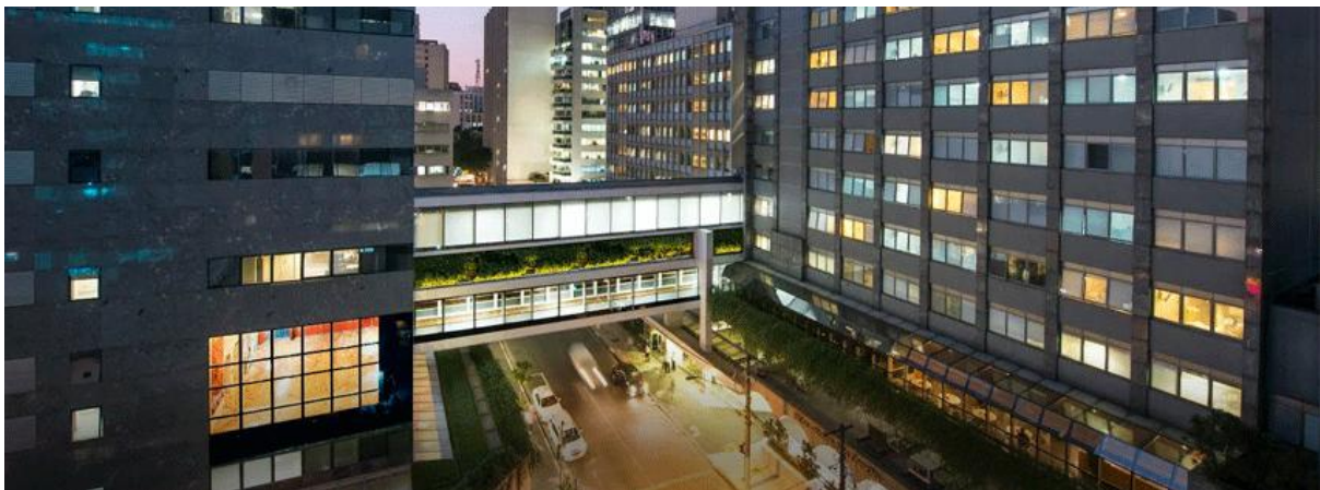
FIG 66 – Passarelas do Edifício Dr. Adib Jatene – SP.
