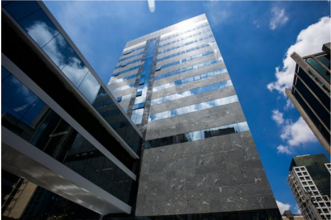
FIG 67 – Fachada do Edifício Dr. Adib Jatene – SP.
