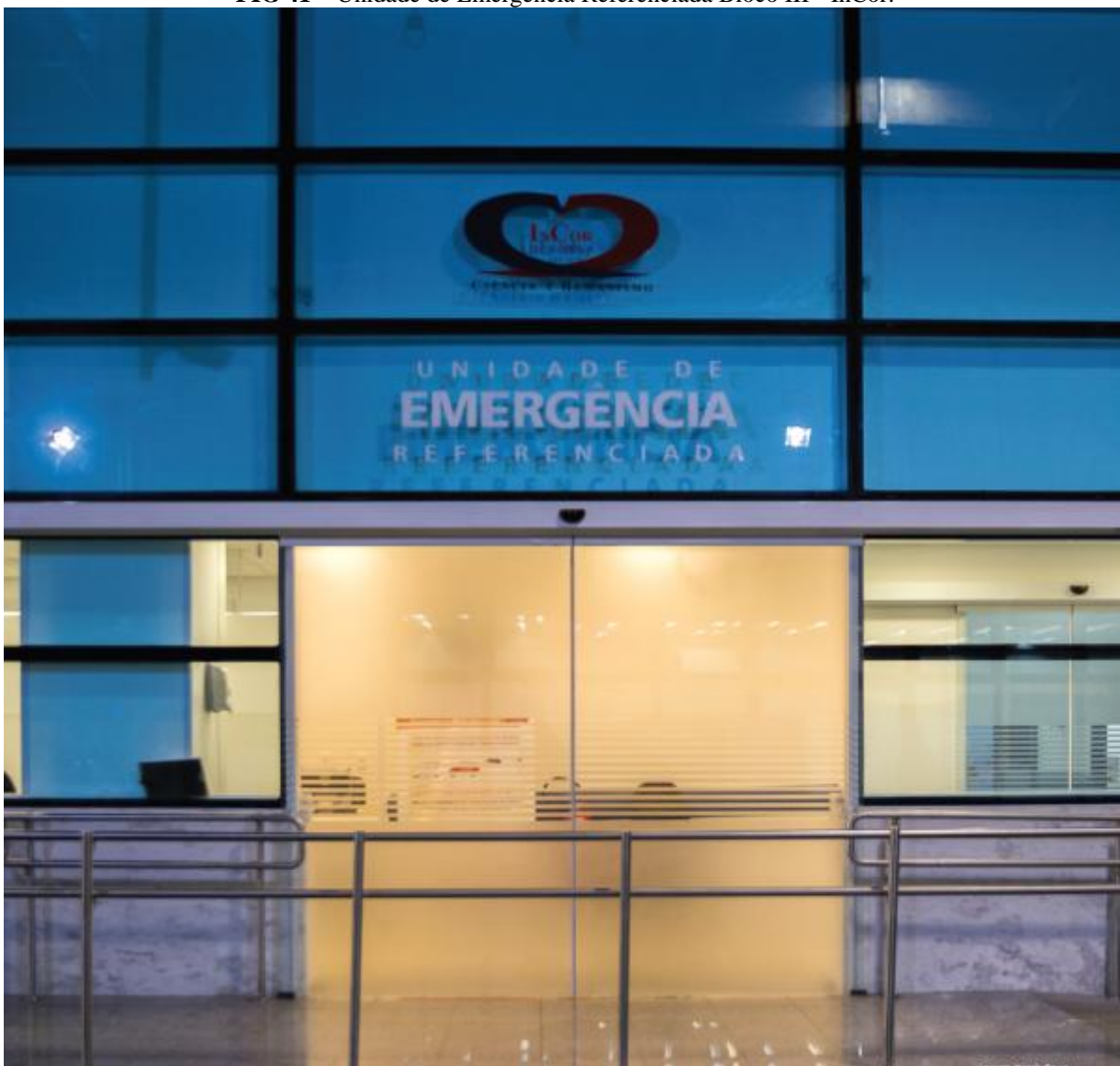
FIG 41 – Unidade de Emergência Referenciada Bloco III - InCor.
