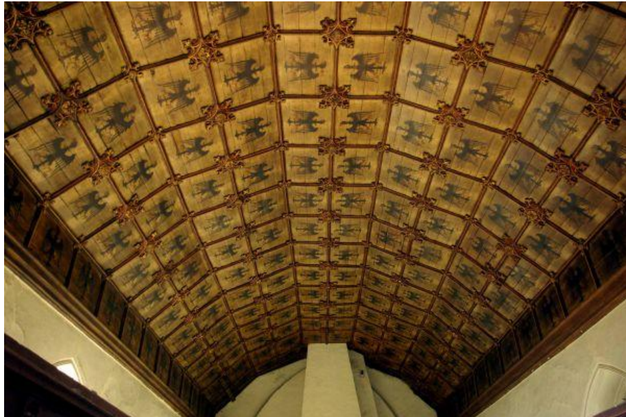
FIG 10 - Enfermaria e detalhe do teto.
