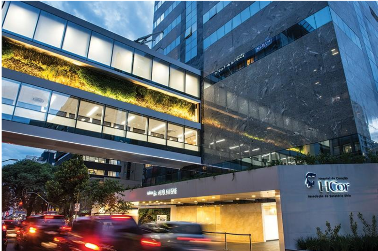
FIG 65 – Vista das Passarelas do Edifício Dr. Adib Jatene – SP.
