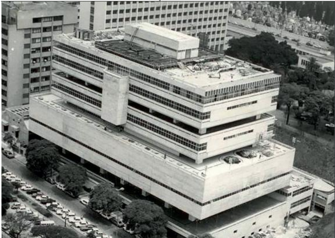
FIG 39 – Primeiras fases da construção do bloco I do InCor, década de 1970 – SP.
