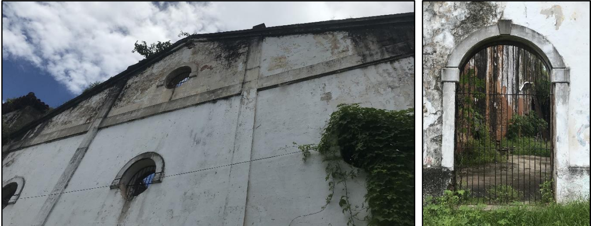
Figura 64 – Frontão industrial e emolduramento de vão
