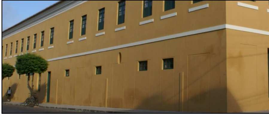
Figura 24 – Detalhe da marcação de antigos vãos suprimidos
