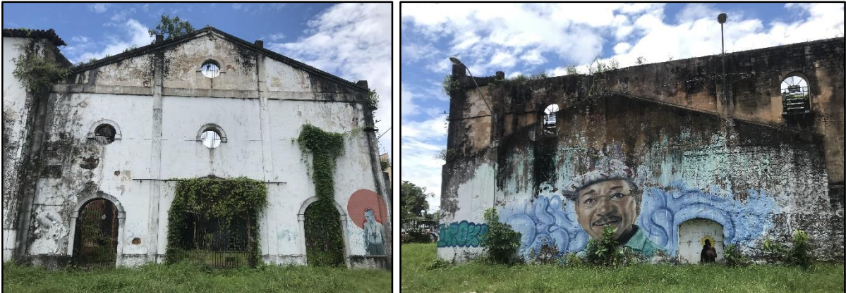
Figura 81 – Aspecto atual da fachada principal e trecho da fachada lateral do Galpão 4.
