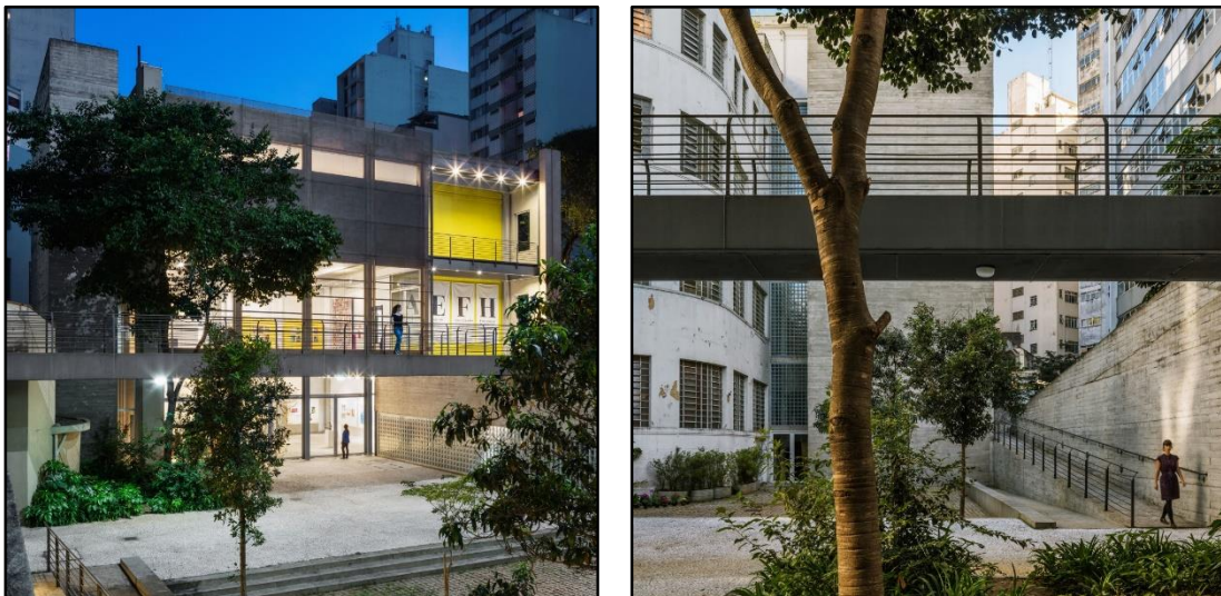
Figura 37 – Vista de elementos em estruturas metálicas, rampas e passarelas.
