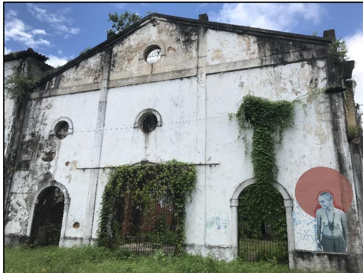
Figura 63 – Fachada principal oeste galpão 4
