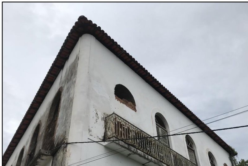
Figura 60 – Vista para o beiral da cobertura com ausência de ornatos
