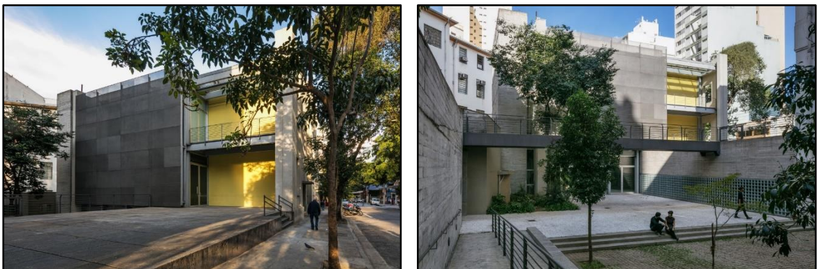
Figura 32 – Praças no nível térreo e subsolo.
