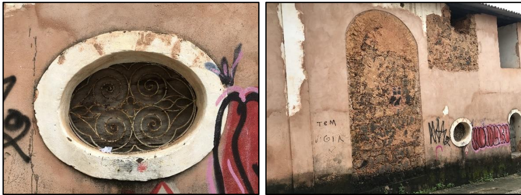
Figura 62 – Detalhe de óculo e vão vedado com pedras irregulares
