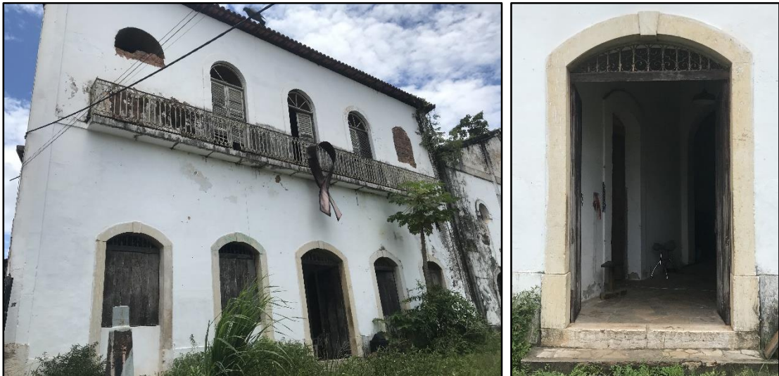
Figura 57 – Fachada principal oeste e vão com verga e ombreiras em pedra lioz
