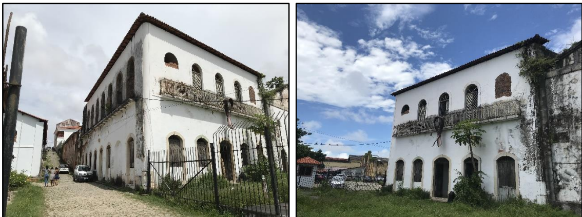
Figura 79 – Aspecto atual das fachadas do Galpão 3, com recomposição do volume após intervenção para sediar Oficina Escola
