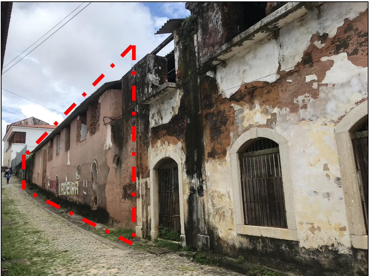
Figura 61 – Marcação de trecho correspondente ao volume acrescentado do galpão 3
