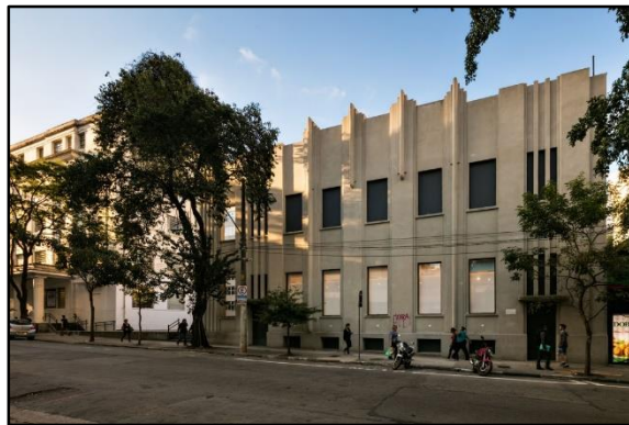
Figura 30 – Fachadas principais dos edifícios Rui Barbosa e Joaquim Nabuco
