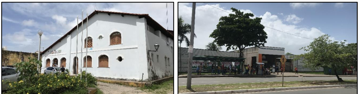
Figura 83 – Centro de Atendimento ao Servidor Público Municipal de São Luis (CEAT) e Terminal de Integração da Praia Grande
