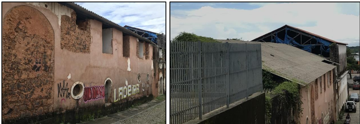
Figura 80 – Trecho da fachada lateral e diferenças de níveis da cobertura do Galpão 3
