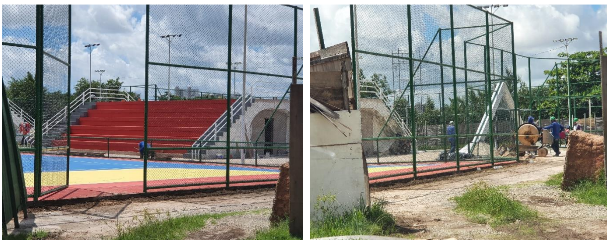
Quadras em reforma.
