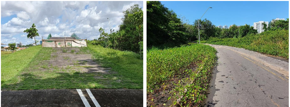
Figura 42 - Acesso ao mirante.
