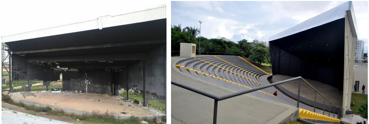
Figura 27 - Antes e depois da reforma da concha acústica.
