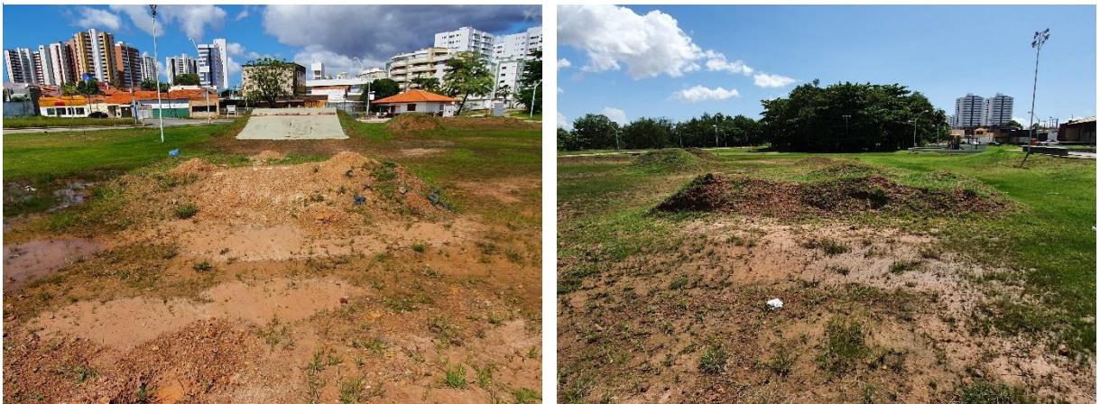
Figura 38 - Pista de bicicross sem manutenção.
