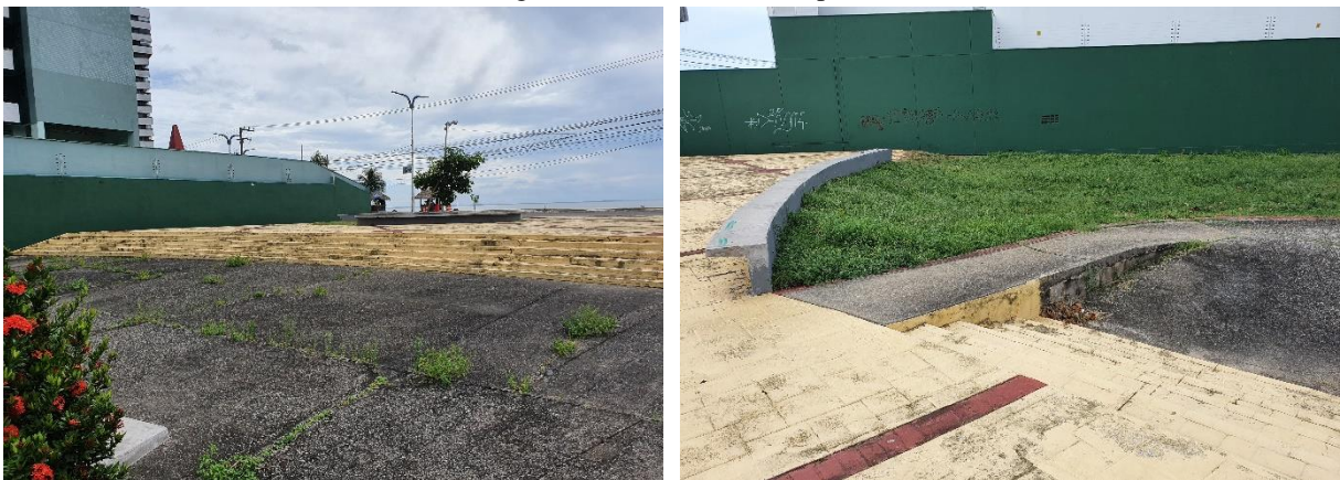
Figura 67 - Escadaria e rampa.
