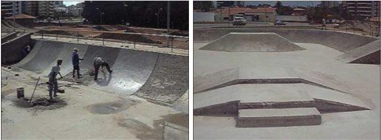
Figura 21 - Construção da pista de skate.
