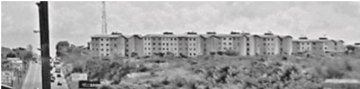
Figura 09 - Conjunto habitacional popular de quatro pavimentos, bairro do Angelim Fonte: Burnett (2006) Urbanização e Desenvolvimento Sustentável, p. 138
