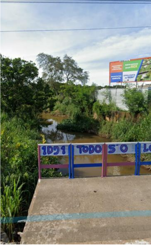
Figura 33 – Leito do Rio Calhau, Av. dos Holandeses Fonte: © Google Earth Pro 2020.
