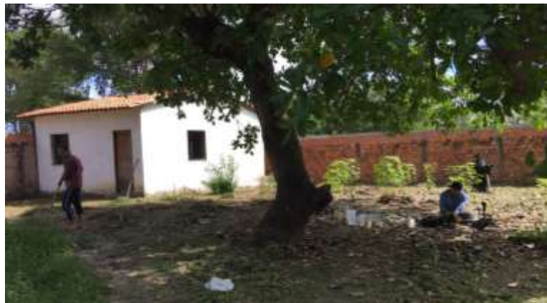
Figura 25 – Serviço de roçagem e capinagem
