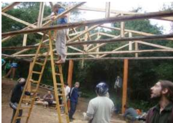
Figura 11 e 12 – Construção da cobertura do Templo da Nação Tutumbaiê – RS
