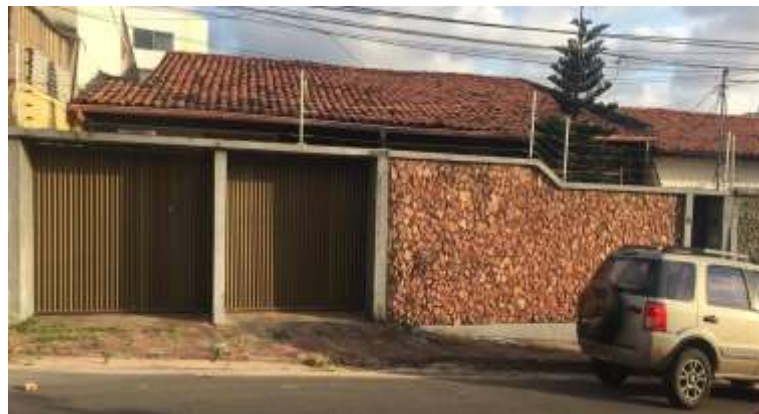
Figura 16 – Residência do Bairro do Cohafuma, São Luís, MA.
