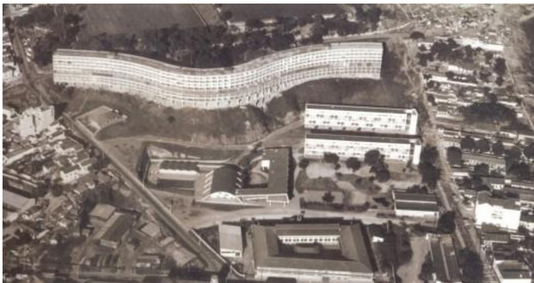
Figura 14 - Conjunto Residencial Prefeito Mendes de Moraes (Pedregulho)
