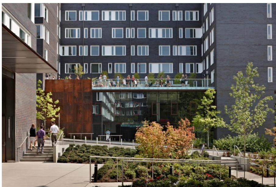
Figura 17 - Usos do Edifício Caiçara
