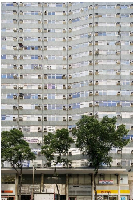
Figura 12 - Edifício Marques do Herval
