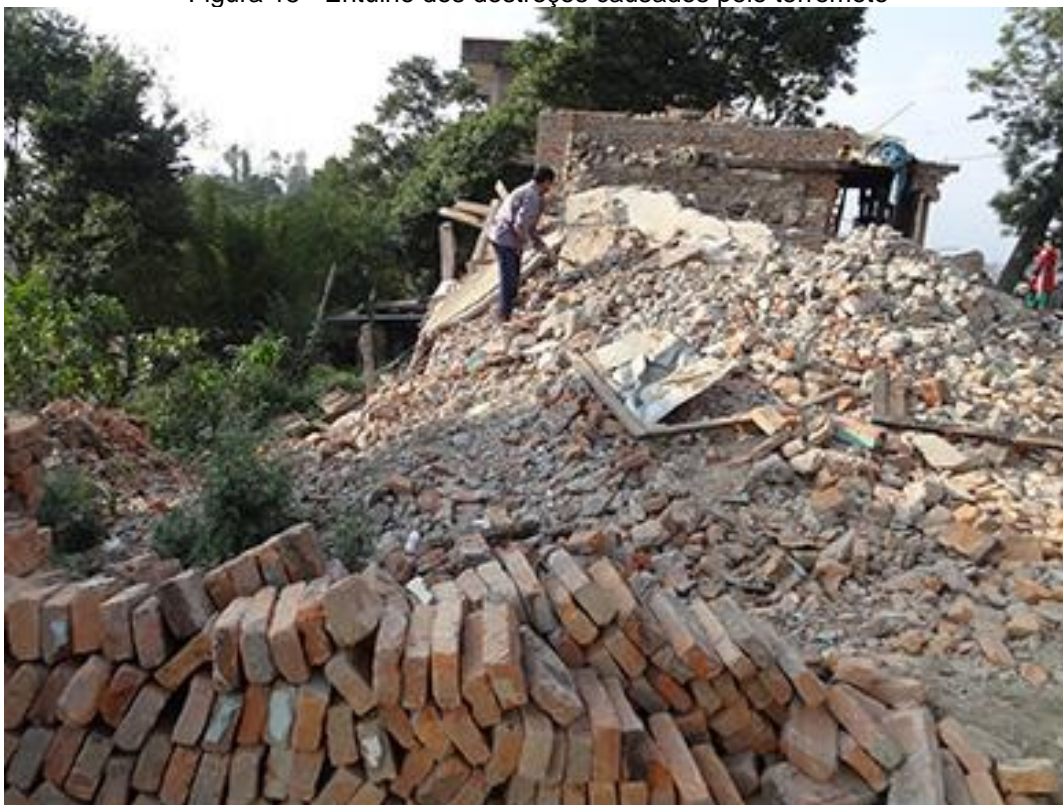
Figura 15 - Entulho dos destroços causados pelo terremoto
