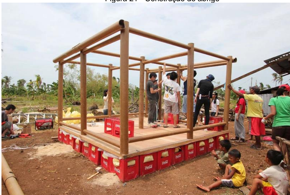
Figura 21 - Construção do abrigo
