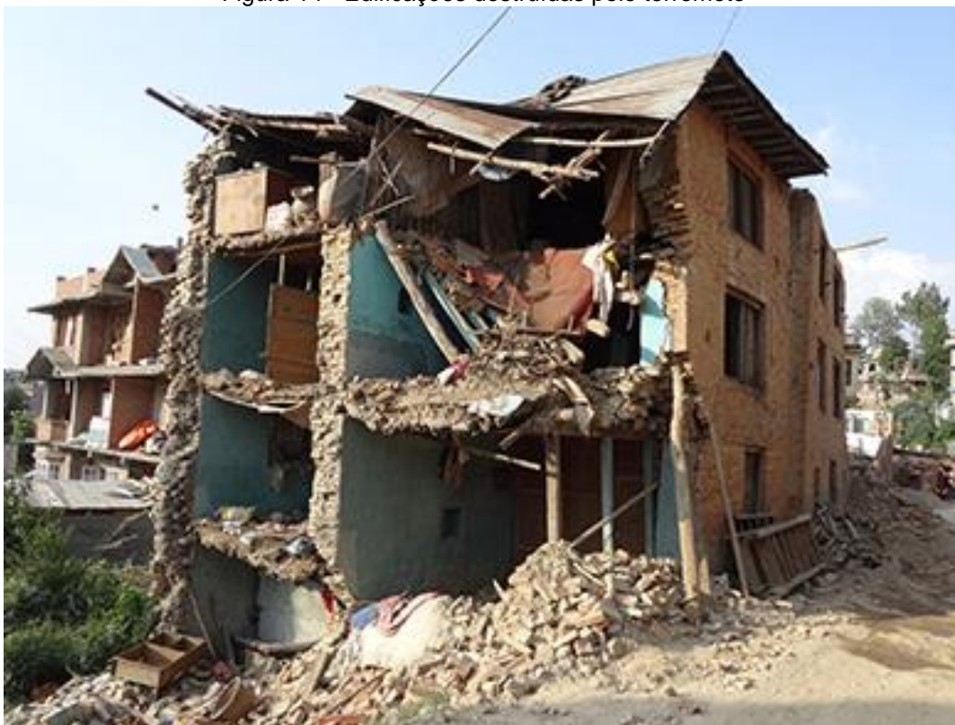
Figura 14 - Edificações destruídas pelo terremoto
