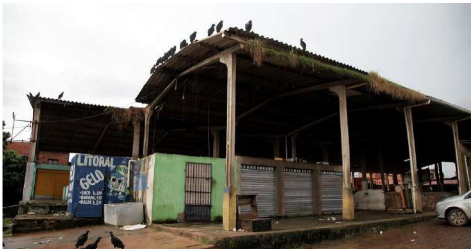
Figura 17– Galpão antes da reforma e ampliação.
