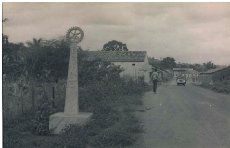
Figura 24 – Entrada da cidade de Pedreiras, MA - 1968
