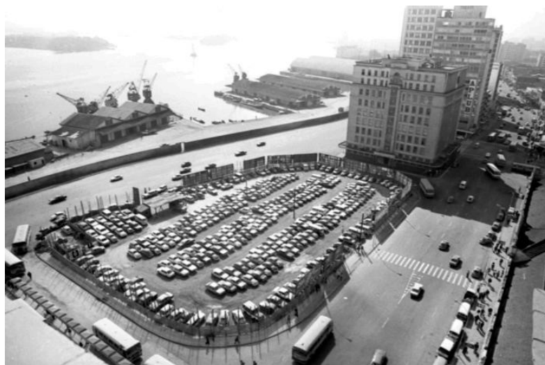
Figura 05– Antigo Mercado Livre, transformado no Estacionamento do Movimento Assistencial de Porto Alegre – RS.
