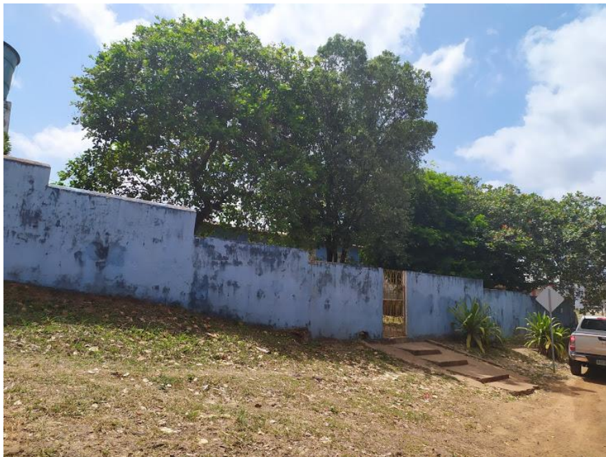
Figura 15 – Fachada Unidade de Ensino Básico Manoela Varela
