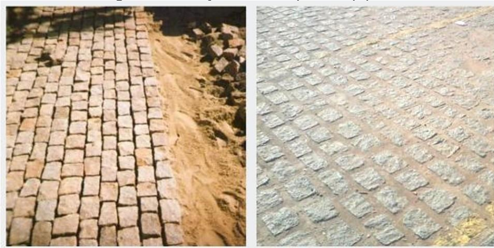
Figura 42 - Calçamento em paralelepípedo
