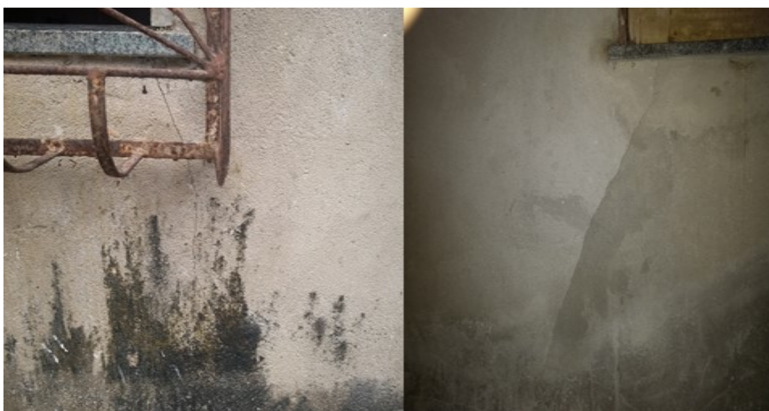
Figura 13 – Fissuras diagonais em esquadrias
