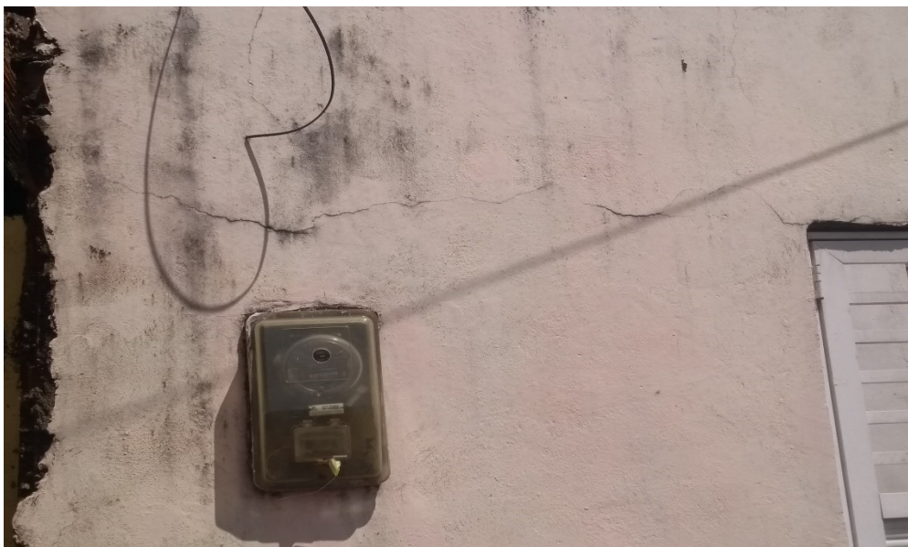
Figura 14 – Fissuras horizontais
