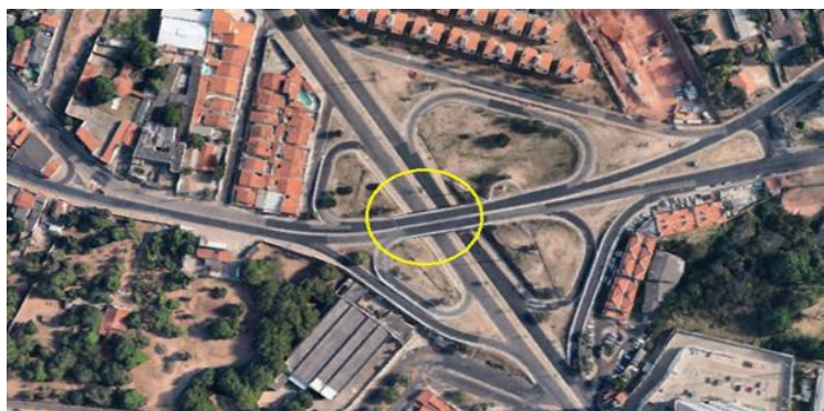
Figura 9: Vista superior do viaduto do café.
