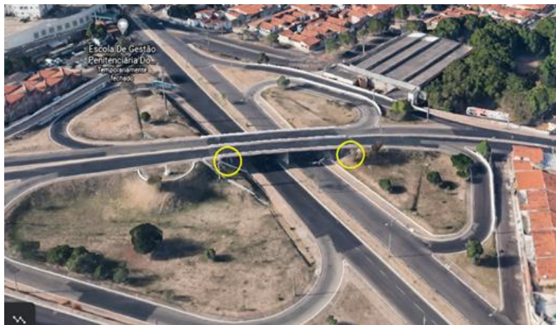
Figura 10: Pontos de exposição no viaduto do café.
