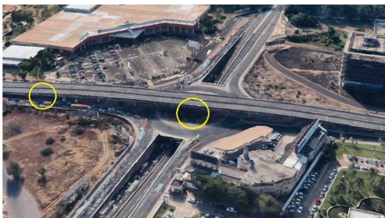
Figura 8: Pontos de exposição no viaduto da COHAMA.
