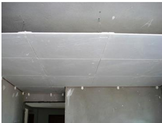
Figura 10 – Aplicação do forro de gesso em reformas de apartamentos.
