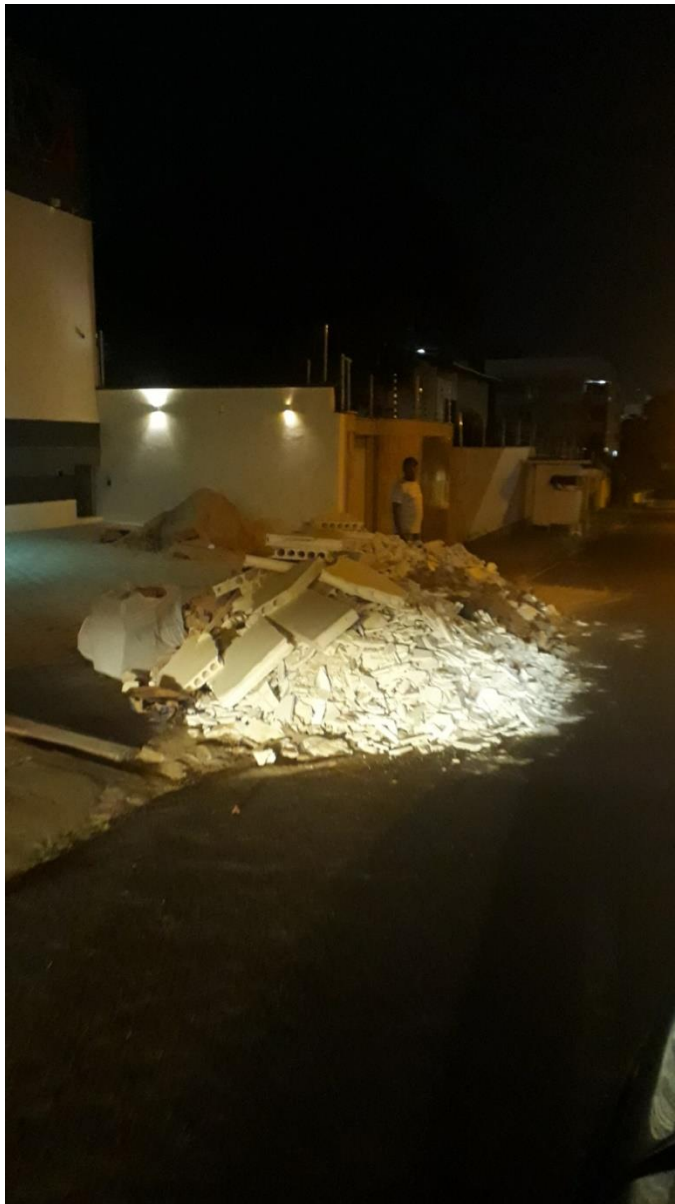
Figura 14 – Resíduo de gesso na rua de São Luís-MA.
