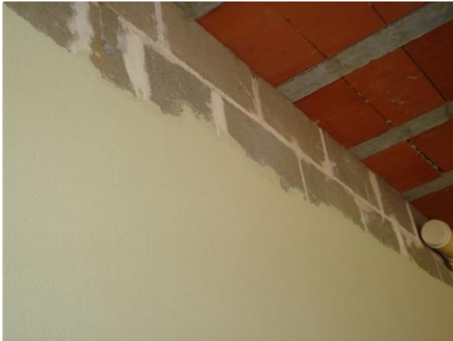
Figura 11 – Parede rebocada revestimento com gesso diretamente na alvenaria.
