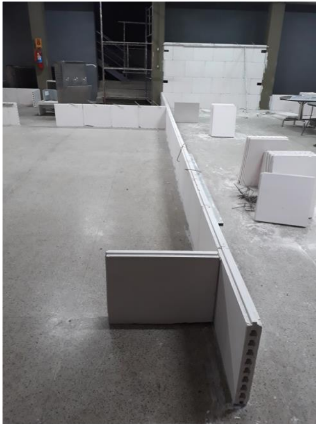
Figura 22 – Blocos gesso utilizado para marcação da parede pátio UNDB.
