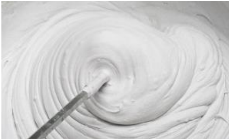
Figura 9 – Mistura de massa pó de gesso com água.
