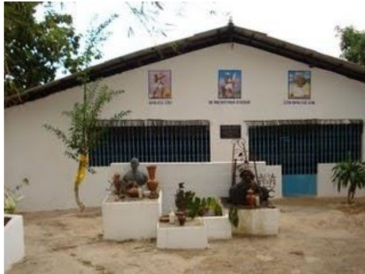
Figura 8. Vista da parte frontal do barracão de Candomblé da Casa Fanti-Ashanti, fechado no final do ano de 2019 por orientação da Defesa Civil, em função do perigo de deslizamento do terreno.
