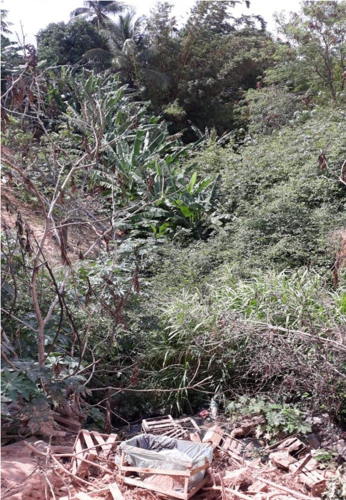
Figura 6 visão da encosta que começa na Rua Militar
