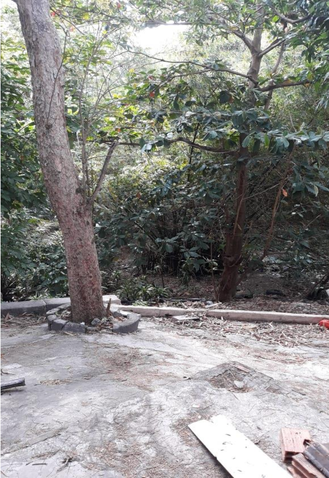
Figura 4 área de forte erosão, nos fundos da Casa Fanti Ashanti
