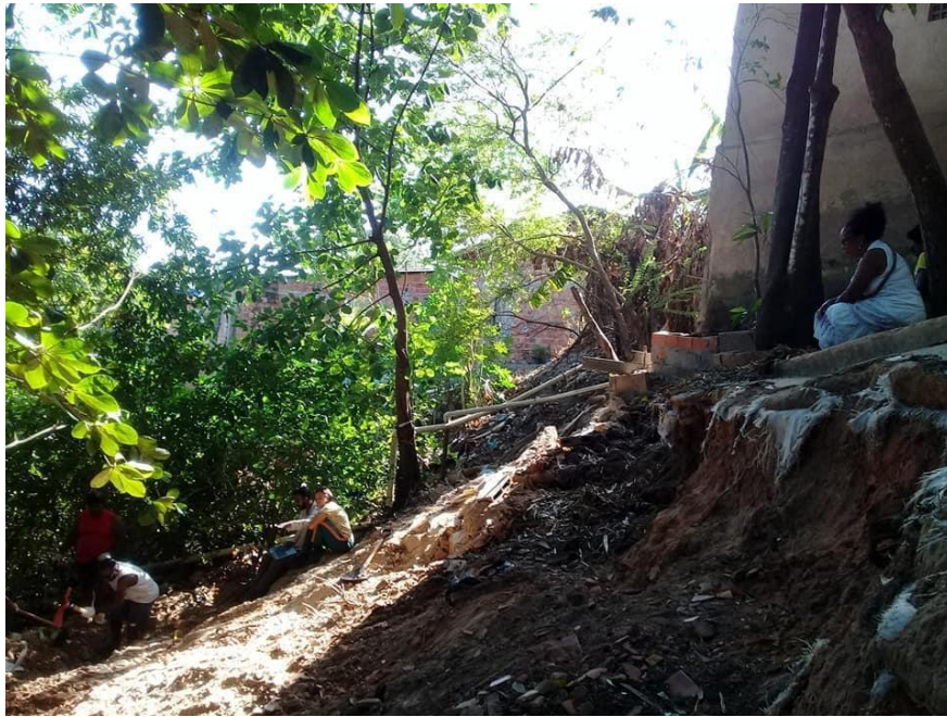
Figura 6. Imagem do início das obras de contenção da encosta na área situada atrás do barracão de Candomblé da Casa Fanti-Ashanti.
