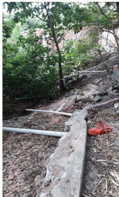
Figura 3. Fotografia da área da encosta localizada aos fundos da Casa Fanti-Ashanti e residências, mostrando a forma como os dejetos são descartados no córrego, antes da intervenção da empresa Curiá e do Governo do Maranhão, em dezembro de 2019.
