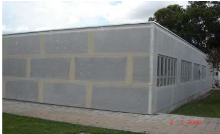
Figura 26 – Tratamento das juntas
