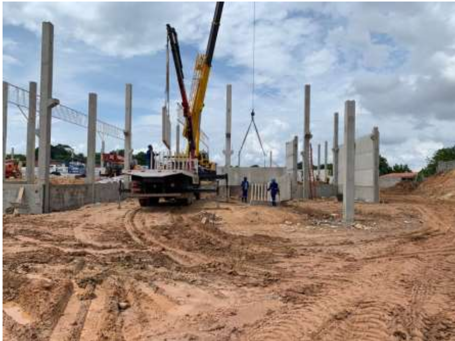
Figura 10 – Distribuição de painéis com munk
