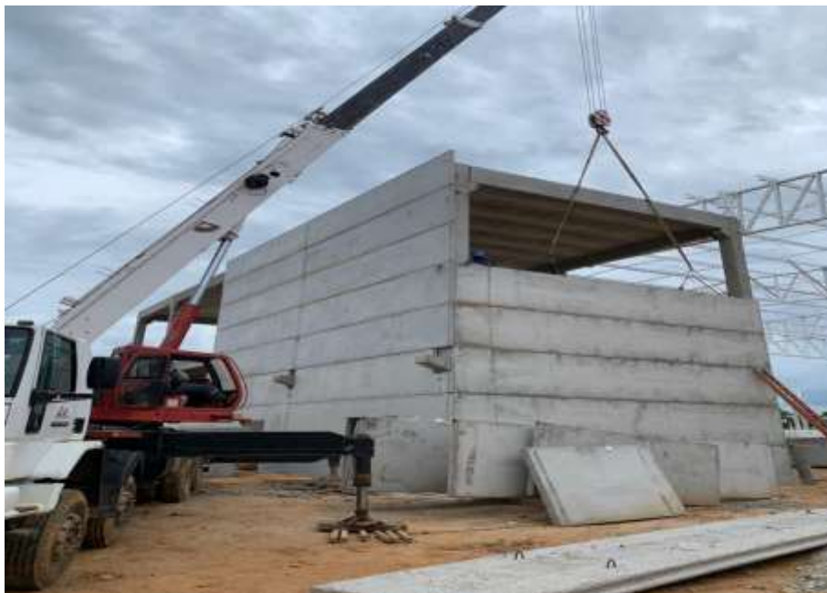
Figura 11 – Montagem com guindaste
