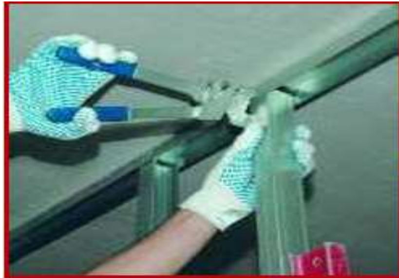
Figura 23 – Preparação da abertura de porta
