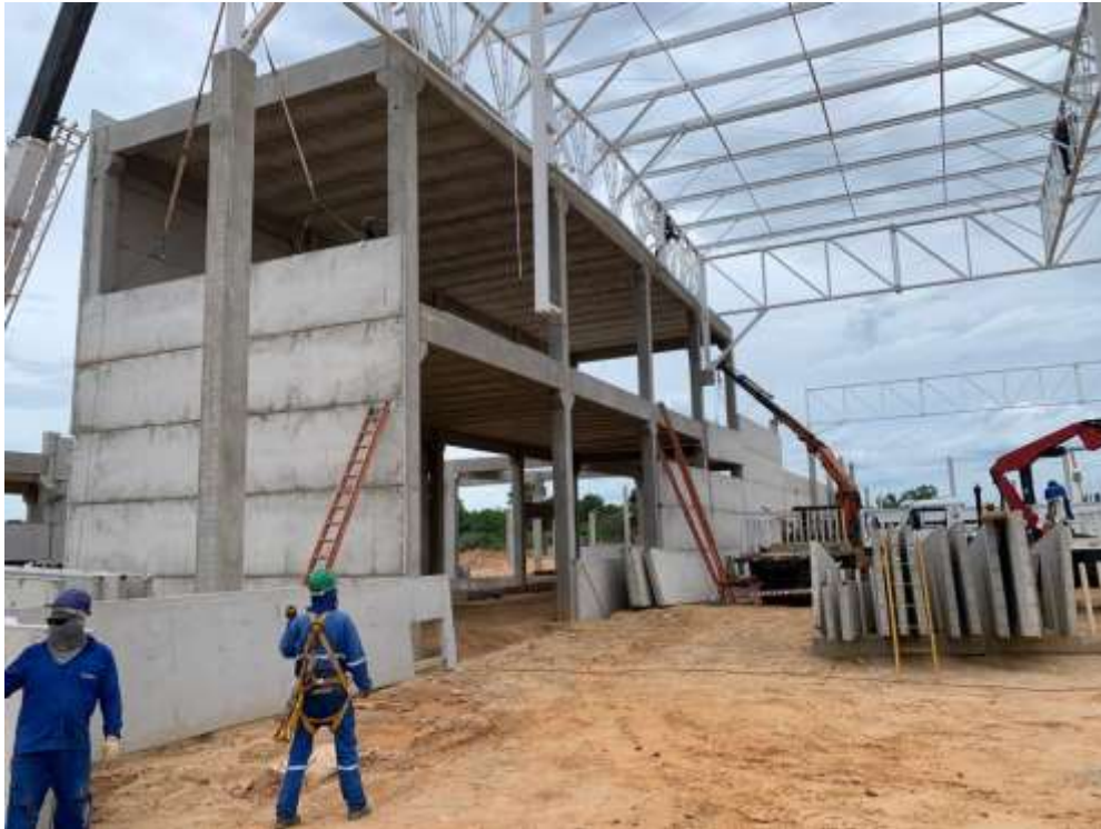
Figura 12 – Armazenamento de painéis
