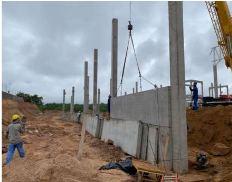
Figura 9 – Montagem de painel
