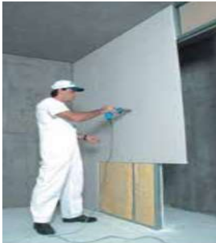
Figura 25 – Fechamento de parede
