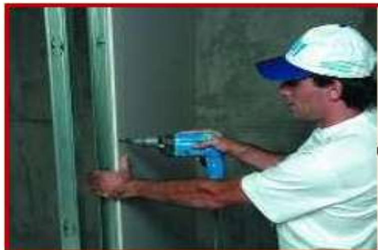
Figura 24 – Fixação de um lado da chapa
