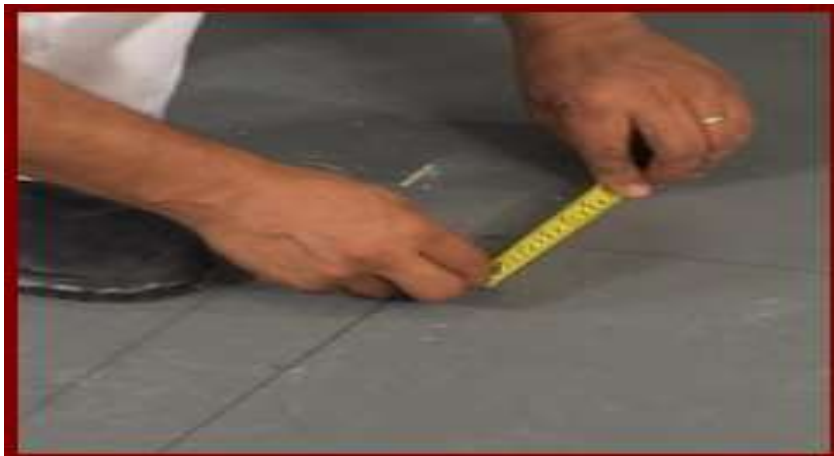
Figura 20 – Marcação e locação da parede
