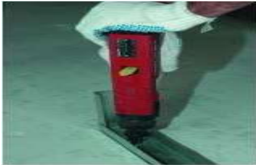
Figura 21 – Fixação das guias no piso
