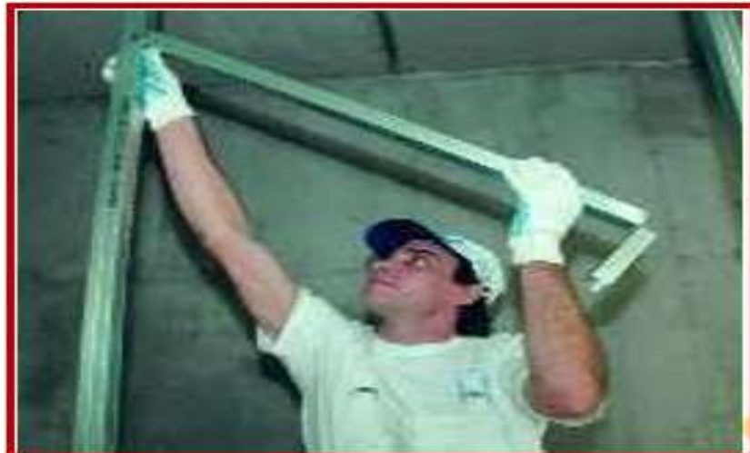
Figura 22 - Fixação dos montantes das guias junto ao piso á laje superior
