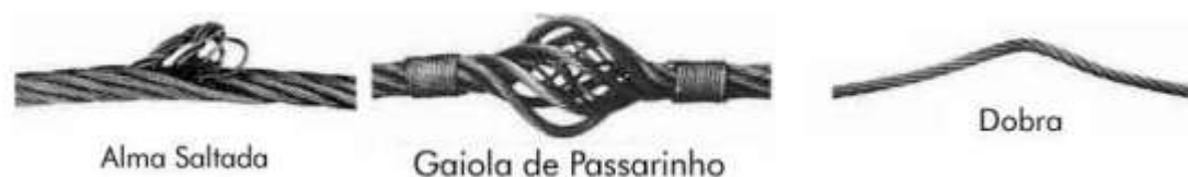
Figura 14 – Inspeção nas ancoragens
