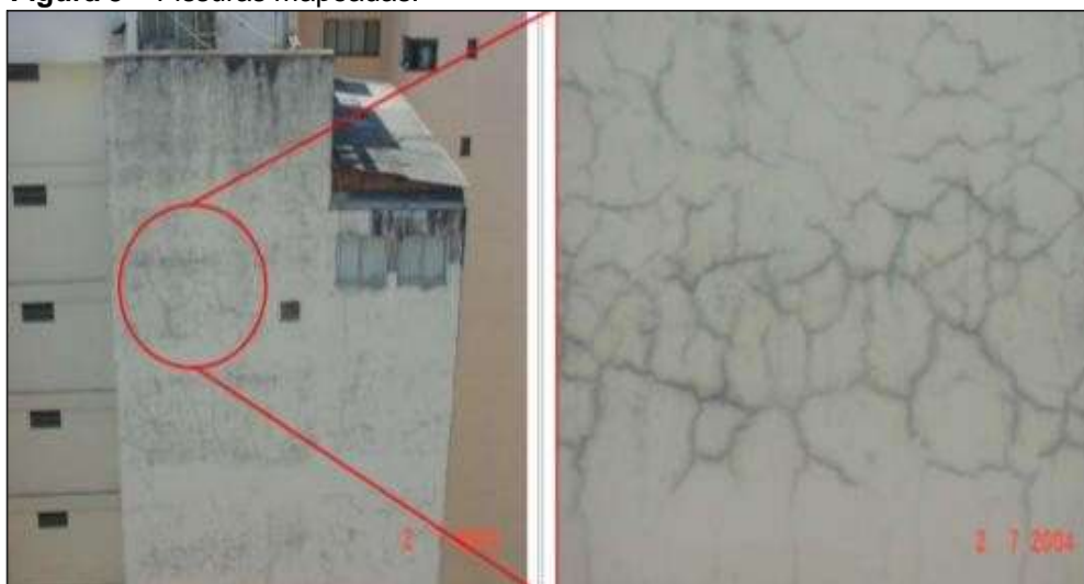
Figura 5 – Fissuras mapeadas.
