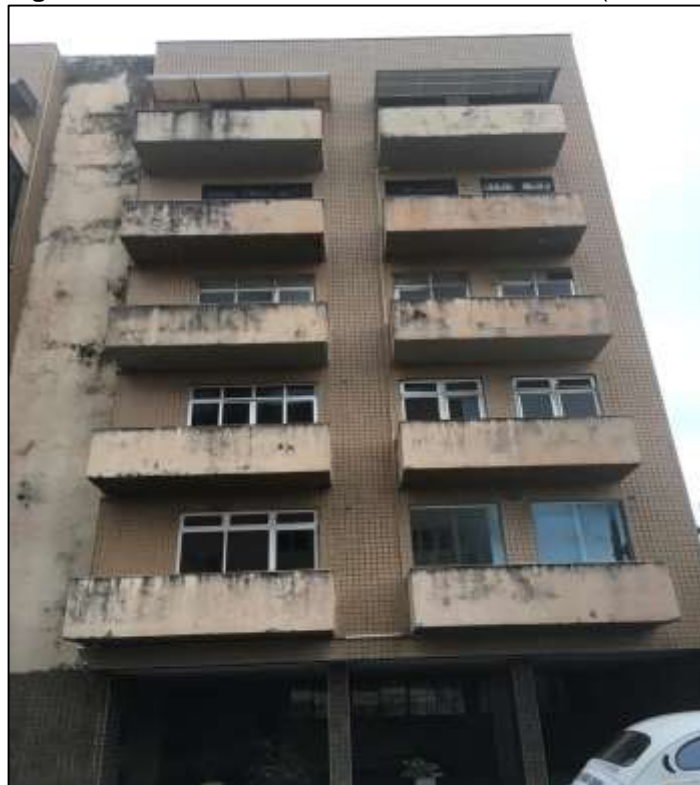
Figura 23 – Edifício do Condomínio Dom Luís I-II (fachada frontal).
