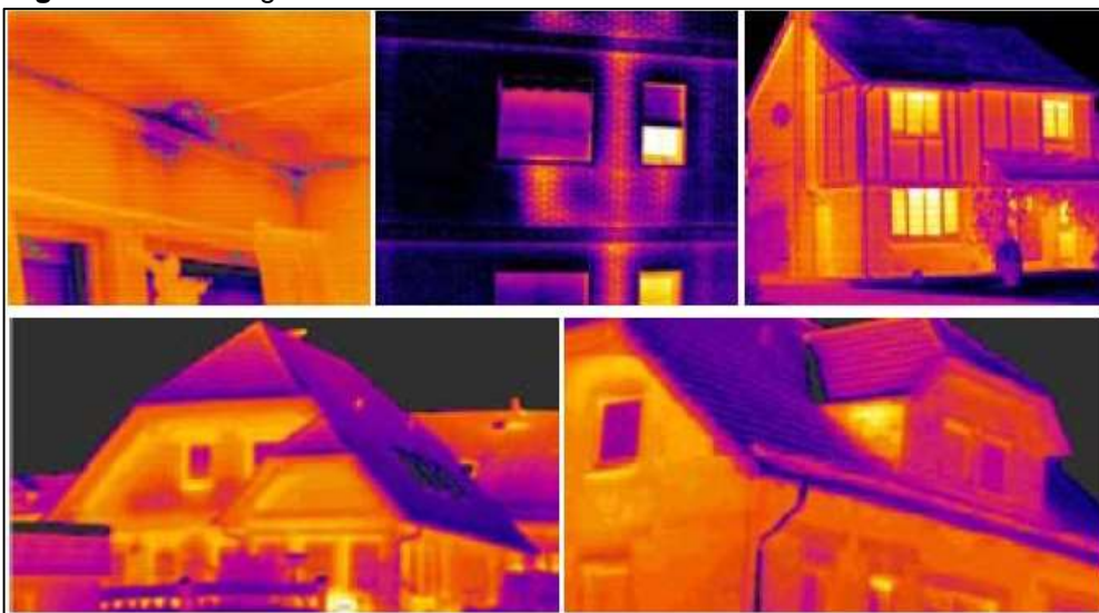
Figura 21 – Termografia em fachada de edifícios.
