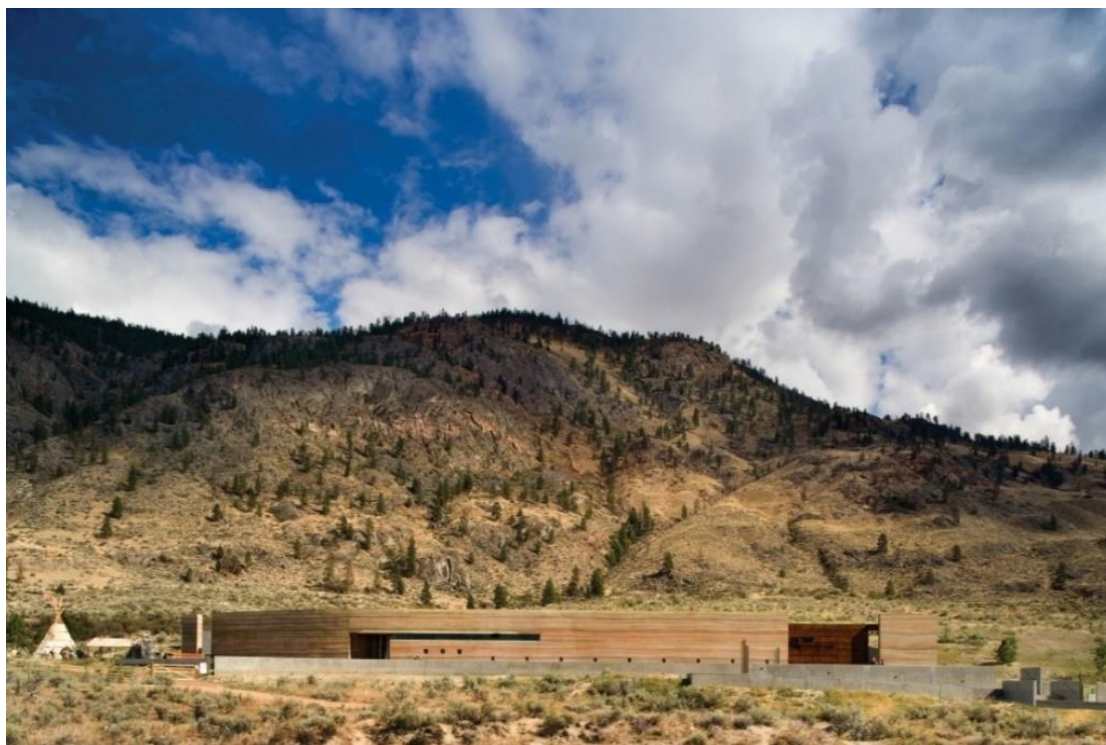
Figura 14: Parede de pedras locais do Centro cultural Nk’Mip.
