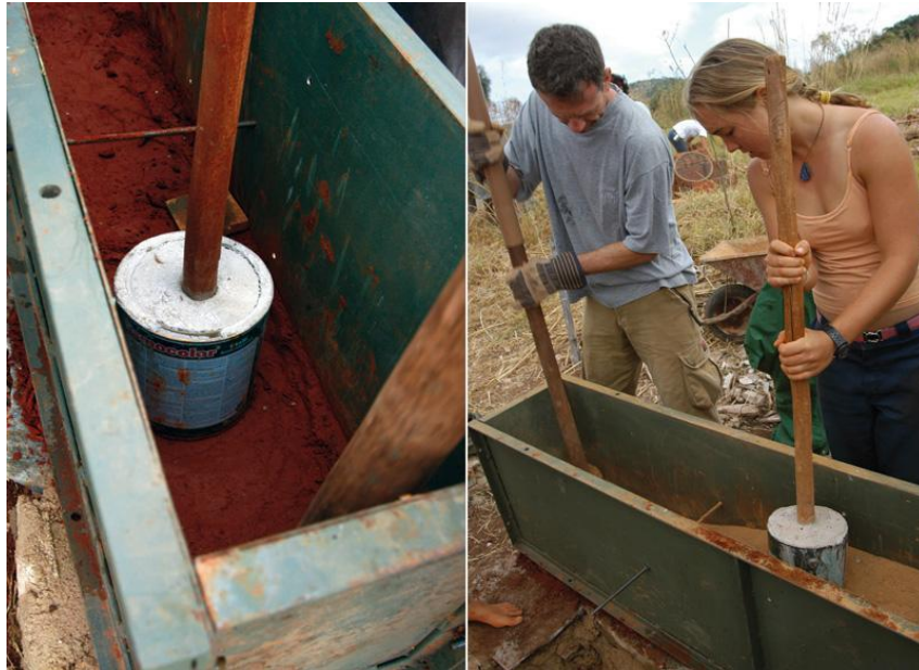
Figura 8: Taipa de pilão.
