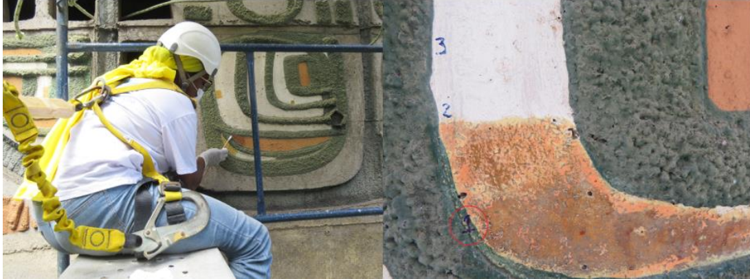
Figura 4: Detalhe das prospecções realizadas química e mecanicamente
