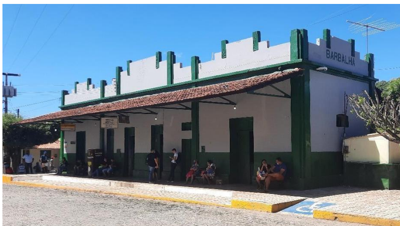
Figura 3: Fachada Noroeste após processo de restauração
