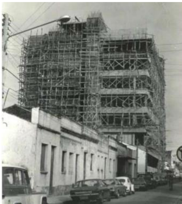
Figura 2: Construção da agência BNB em Juazeiro do Norte.
