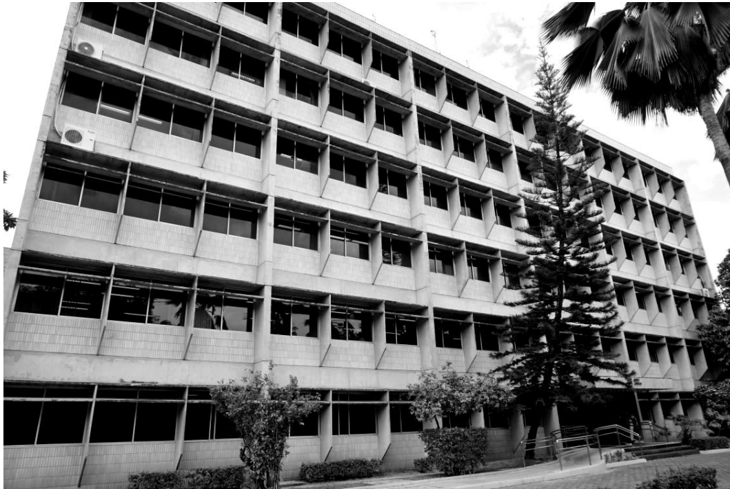
Figura 29: Bloco administrativo da CBTU. Foto dos autores, 2017.
