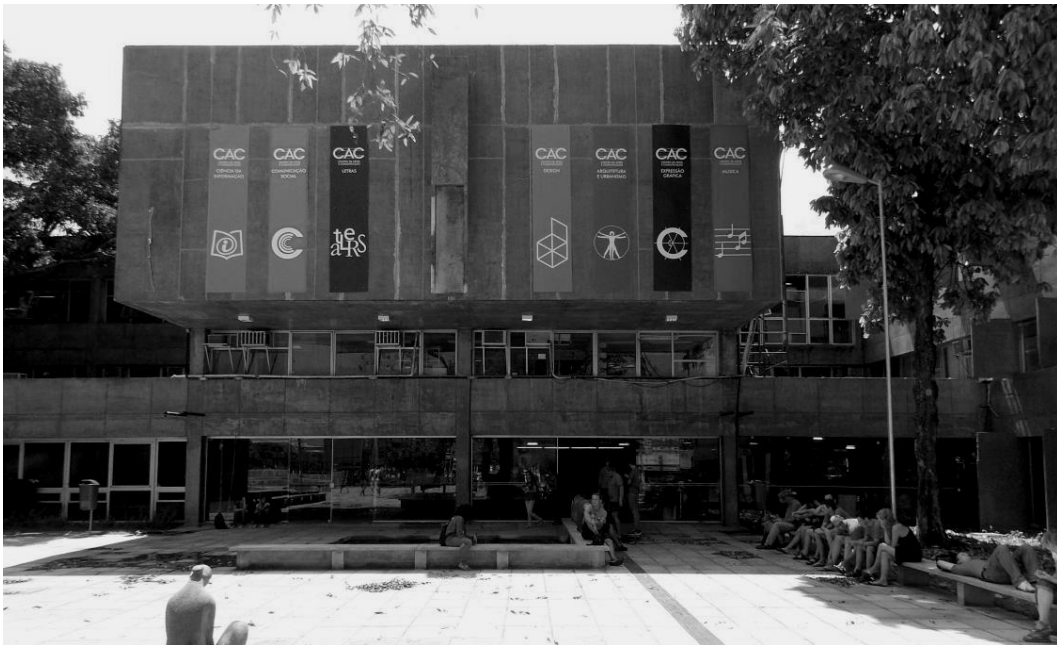
Figura 26: Vista de um dos volumes de acesso, e sua grande gárgula de escoamento. Foto dos autores, 2017.
