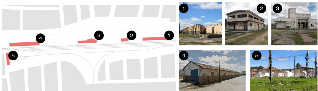
Figura 2: Edifícios que compõem o pátio ferroviário.
