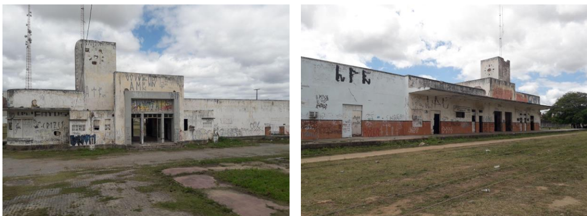
Figura 3 e 4: Edifício da Estação.
