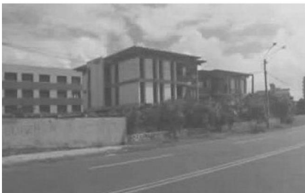
Imagem do Edifício Benício Diógenes Fonte: Acervo Nícia Paes
