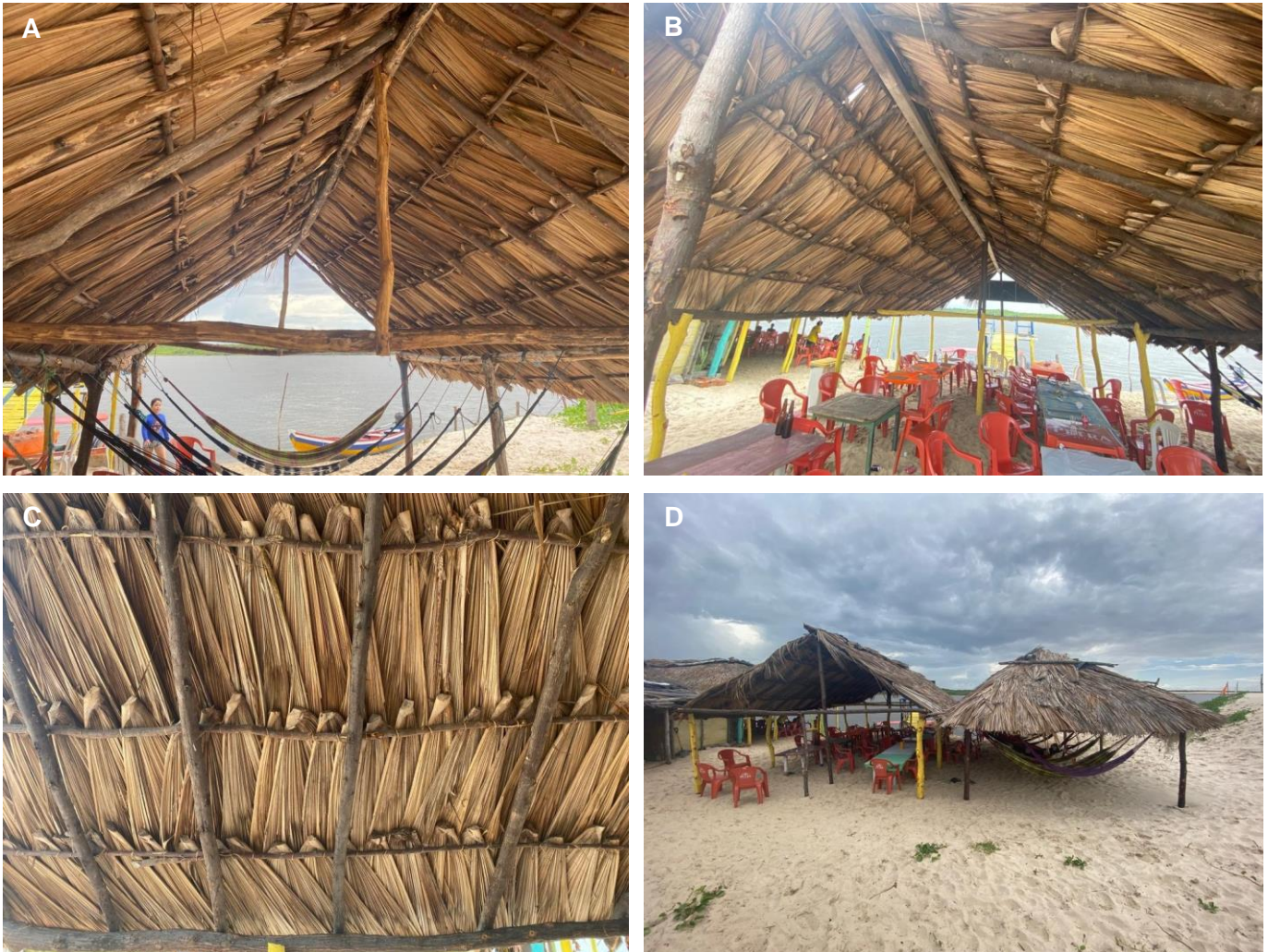
Figura 12– A: Cobertura redário; B: Cobertura do restaurante; C: Detalhe cobertura de telha de buriti; D: Vista externa construção com cobertura de palha de buriti
