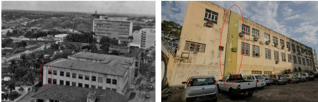
Figura 04 - Foto 1: antiga Sede da Receita Federal - 1968 / Foto 2: antiga Sede da Receita Federal - 2011 - Edição das autoras para destacar volume acrescentado à edificação posteriormente ao projeto original, utilizando vista da fachada da Rua Batista das Neves.
