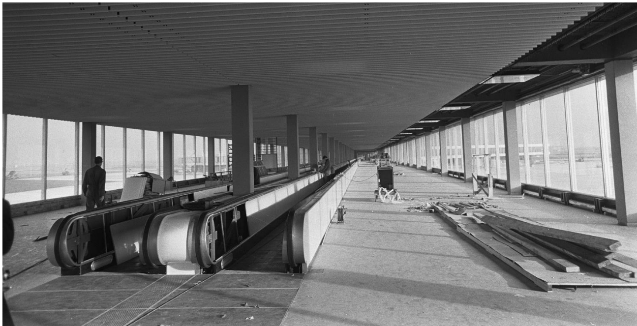
Figura 6 – Pier com 225 metros de Comprimento - Terminal de Passageiros do Aeroporto de Schiphol, em construção
