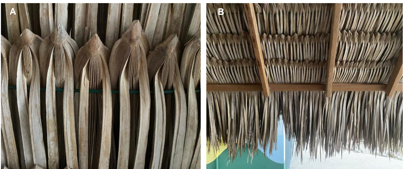
Figura 12– A: Detalhe de amarração de palha de carnaúba; B: Detalhe cobertura com palha de carnaúba
