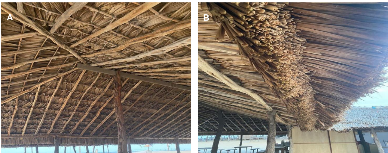
Figura 11– A: Cobertura de palha de buriti e junco; B: Beiral com palha de junco
