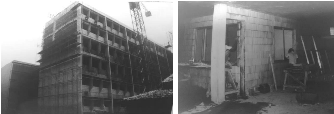
Figura 31-32: A esquerda, edifício da sede em construção. A direita, aplicação da cerâmica de acabamento. Fonte: Acervo CBTU
