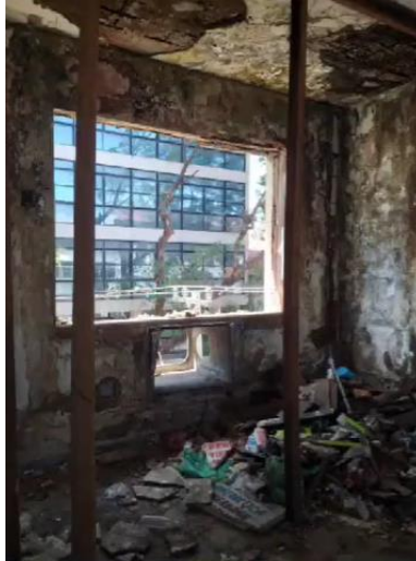
Figura 4: Edifício Bequimão antes da reforma
