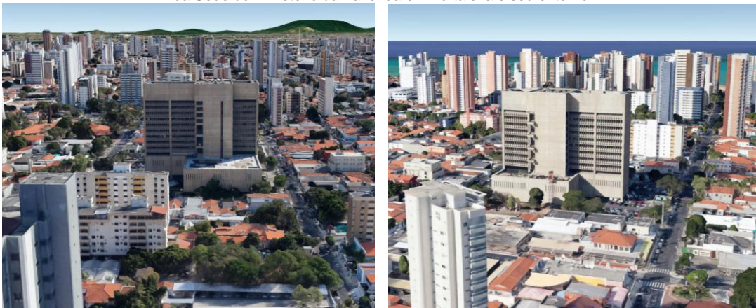
Figura 4: Fachada norte-nordeste (à esquerda) e fachada sul-sudeste (à direita) da Sede do Ministério da Fazenda em Fortaleza e seu entorno
