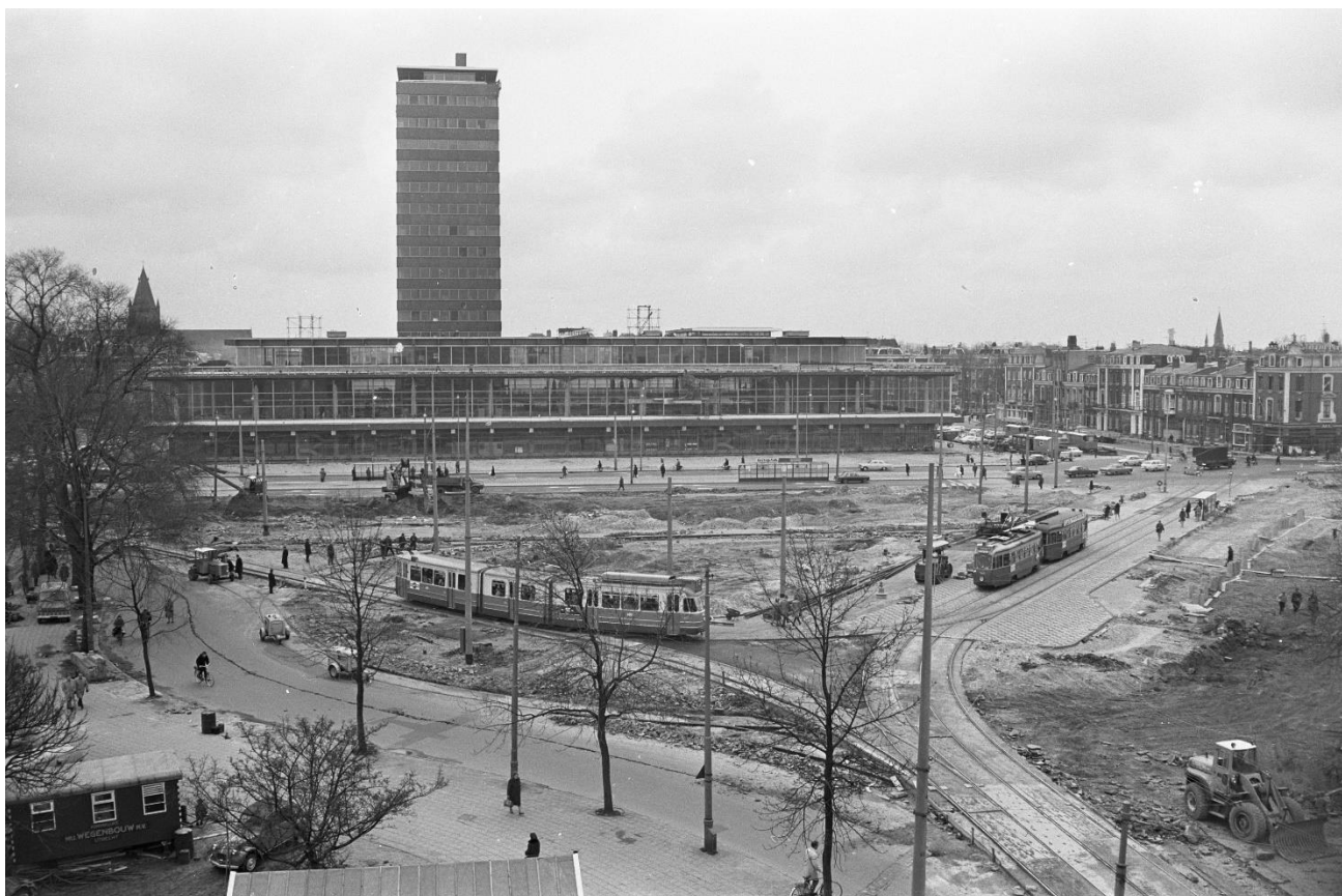
Figura 3 – Banco Holandês - Freeriksplein, em construção
