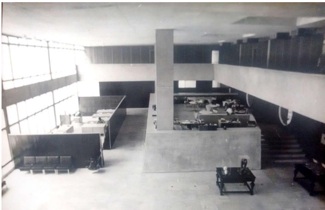
Figura 7: Vista do foyer de entrada e dos seus desníveis. Fonte: Acervo histórico da Biblioteca
