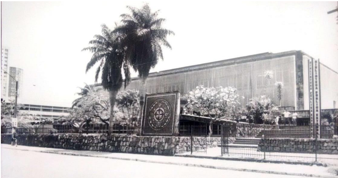
Figura 5: Vista externa da Biblioteca Pública Estadual. Fonte: Acervo histórico da Biblioteca
