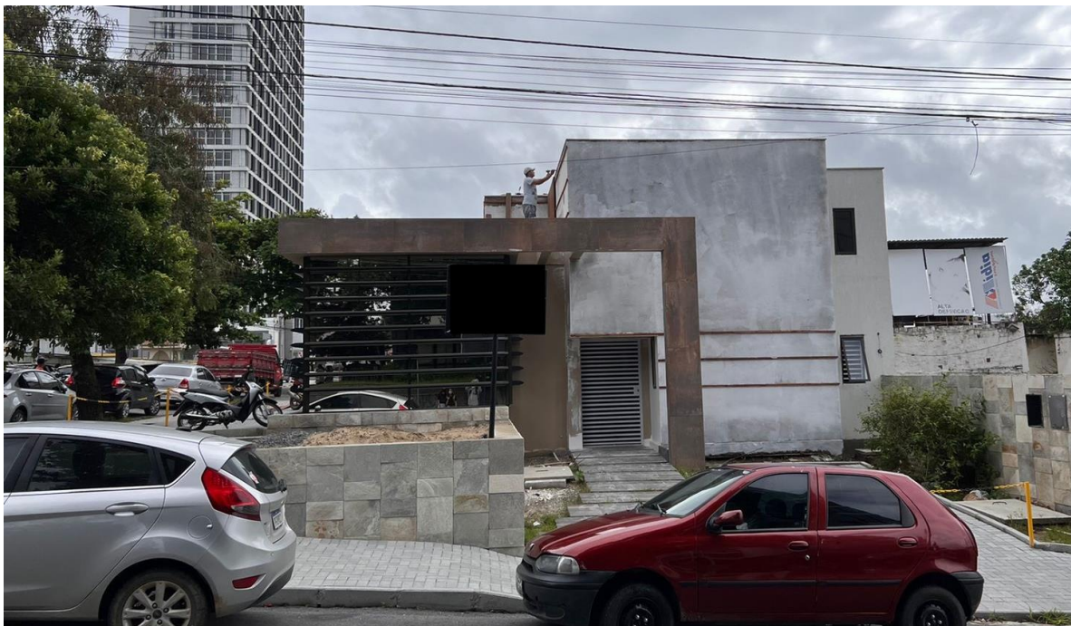
Figura 3: Estado atual da edificação: em processo de descaracterização.
