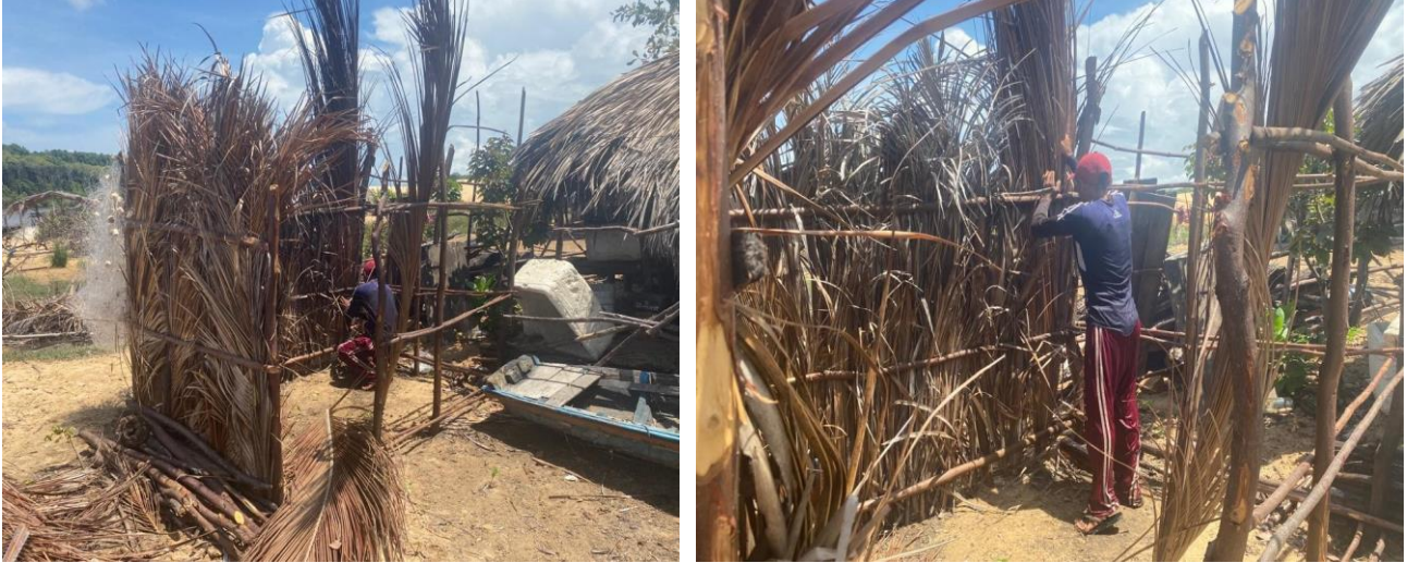
Figura 10– Construção de banheiro com palha de coco
