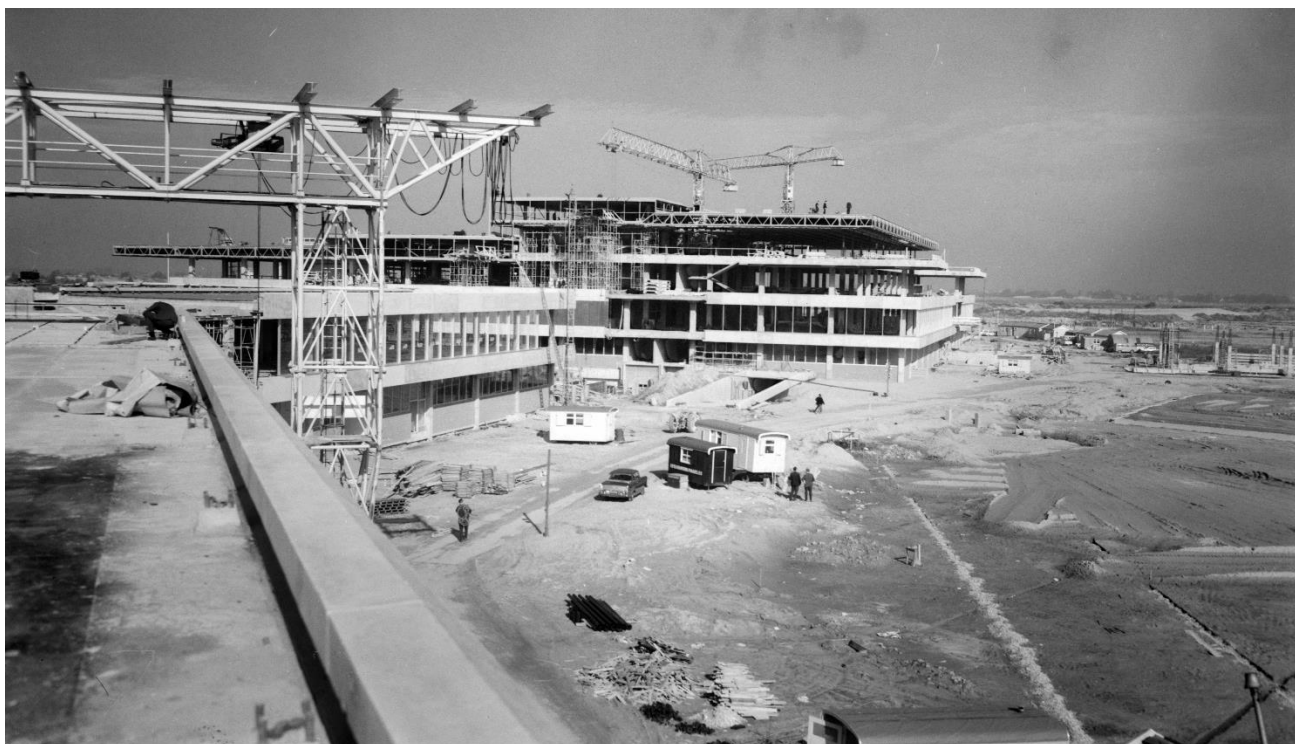
Figura 5 – Terminal de Passageiros do Aeroporto de Schiphol, em construção
