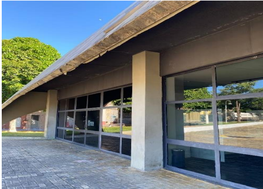
Figura 7: Esquadrias da edificação
