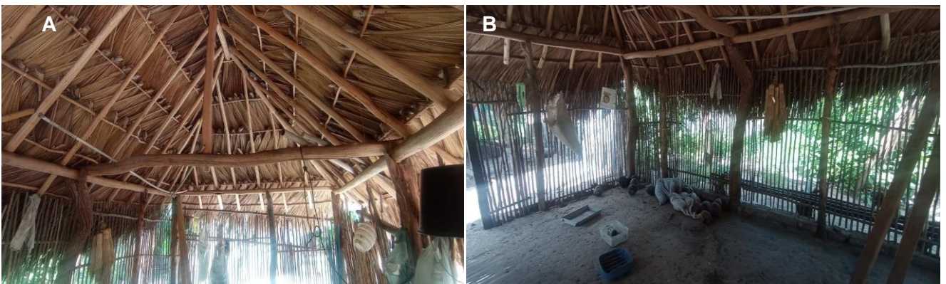
Figura 14 – A: Estrutura cobertura em palha de buriti; B: Alvenaria de vedação com ripas de madeira
