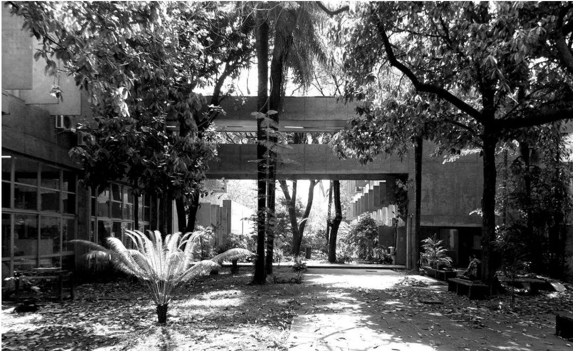
Figura 28: Vista do pátio interno central. Foto dos autores, 2017.
