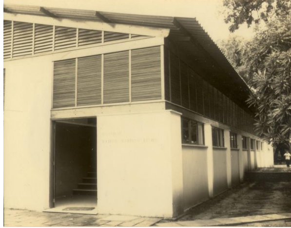
Figura 4: Pavilhão Reitor Martins Filho, destaque para o coroamento em venezianas de madeira.
