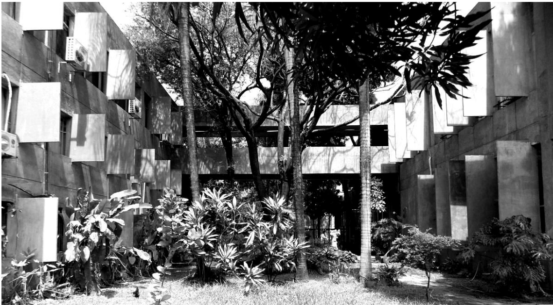
Figura 27: Vista de um dos pátios internos. Foto dos autores, 2017.
