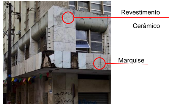
Figura 3: Detalhe da marquise
