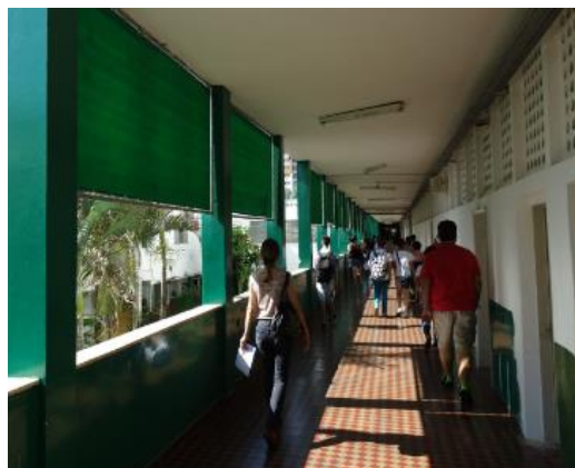
Figura 14: Janelas das salas de aula IFMT
