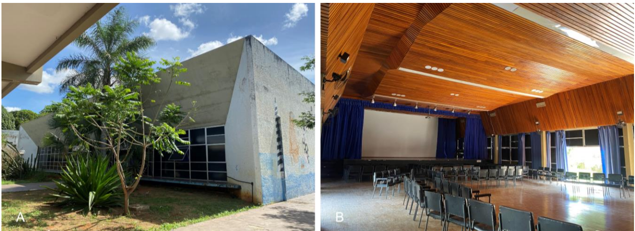
Figura 6 – Fechamento lateral em concreto e frentes com fechamento em esquadria de alumínio e vidro no auditório (A); Interior do auditório (B).
