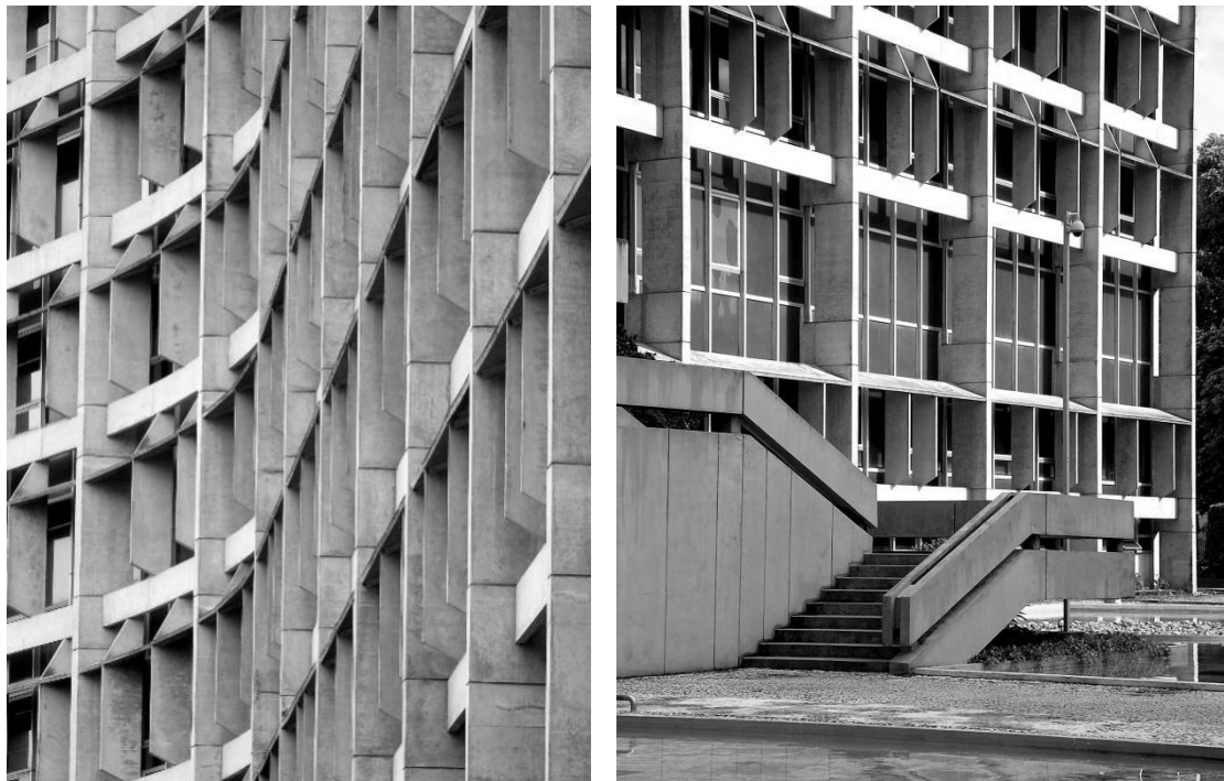
Figura 15: Detalhe das grelhas de concreto que compõem as fachadas leste/oeste do edifício. Foto dos autores, 2014. Figura 16: Vista da escadaria repleta de detalhes de encaixes das peças de concreto. Foto dos autores, 2014.
