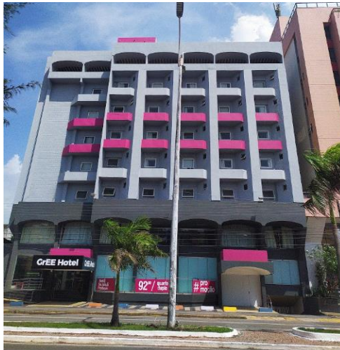
Figura 2 – Fachada do Green Hotel
