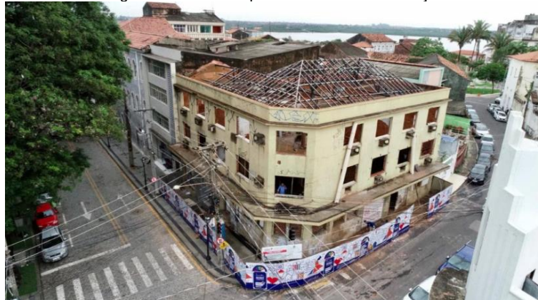
Figura 2: Edifício Bequimão durante a intervenção.
