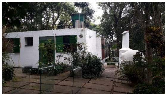
Figura 4: Fachada dos fundos
