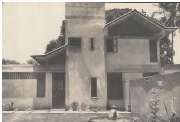
Figura 5: Imagem da Casa dos Arquitetos, destaque para o desenho da fachada frontal.
