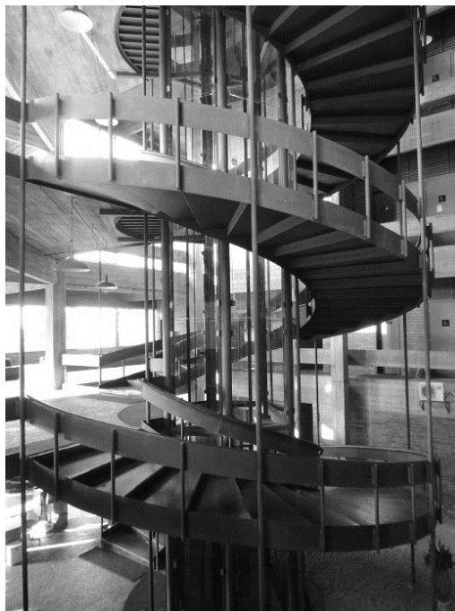
Figura 8: Detalhe da escada helicoidal
