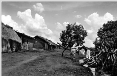
Figura 10: Casas e casebres nas Margens do Córrego Botafogo, década de 1930.
