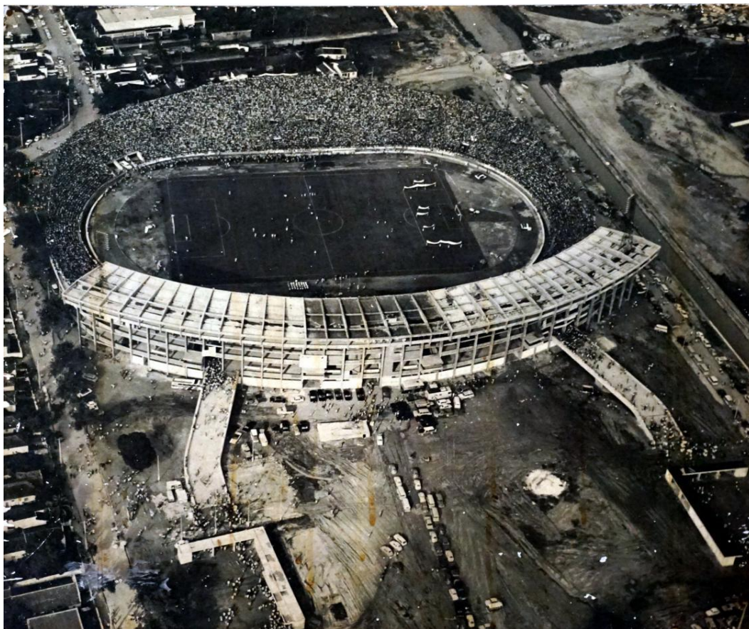
Figura 17: Vista geral do estádio ainda sem o setor administrativo e de lazer construído. Fonte: Arquivo Santa Cruz Futebol Clube.
