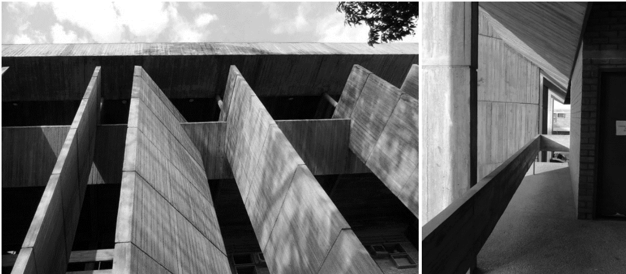
Figura 7: Detalhes dos brises em concreto armado e varandas
