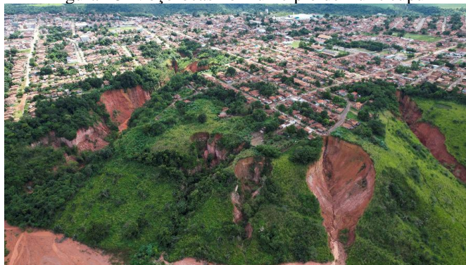
Figura 18- Voçorocas no município de Buriticupu
