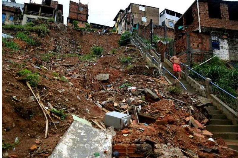
Figura 23-Deslizamento em Franco da Rocha São Paulo
