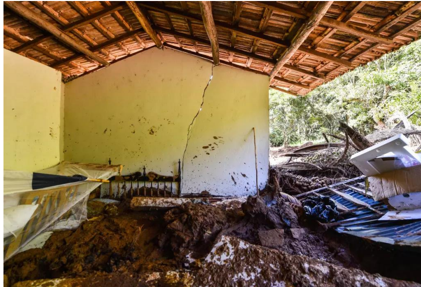
Figura 12 – Casa destruída em catástrofe de Brumadinho
