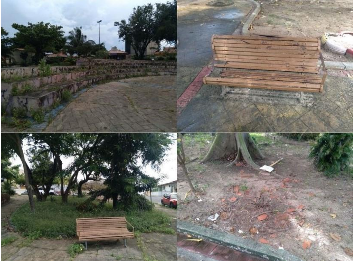
Fotografia 4 – Estado precário de manutenção e conservação de equipamentos da Praça do Viva Renascença (2023)
