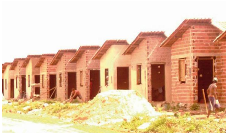
Figura 24 - Construção das Casas do Conjunto.
