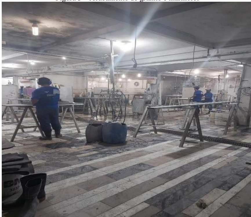
Figura 3 – Acabamento de granito e mármore
