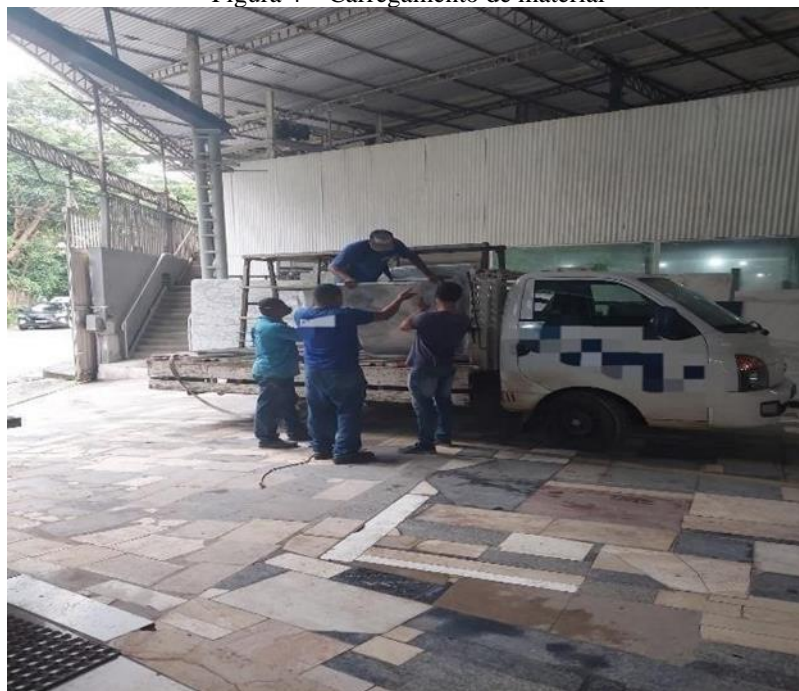
Figura 4 – Carregamento de material
