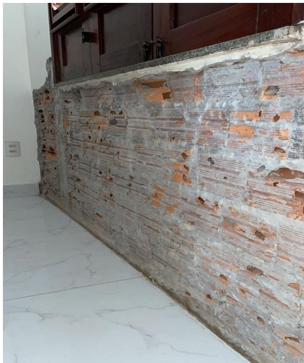
Figura 23 – Retirada do reboco e chapisco da parede
