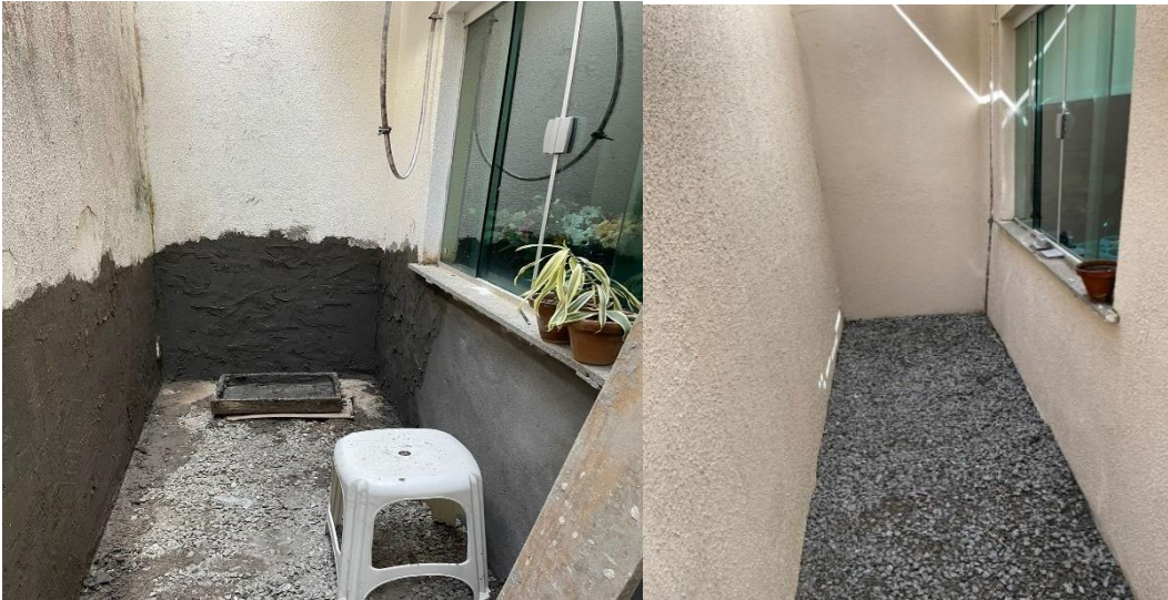
Figura 27 – antes e depois do processo de impermeabilização da parede
