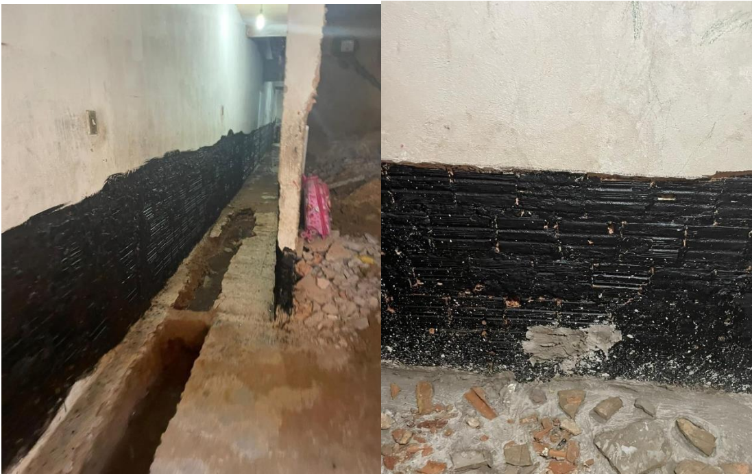
Figura 24 – Impermeabilização dos tijolos cerâmicos
