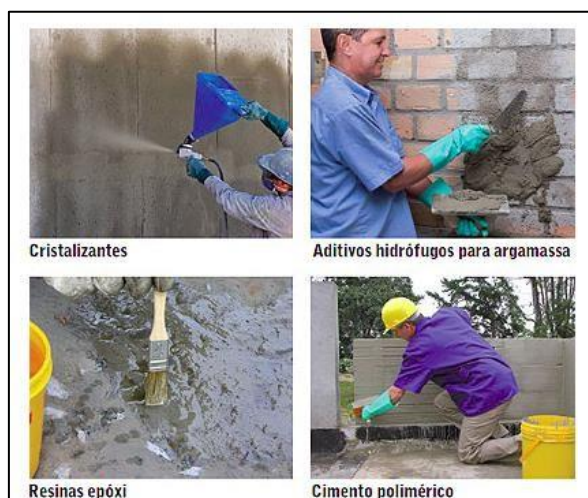
Figura 11 - Impermeabilização Rígida - Materiais.
