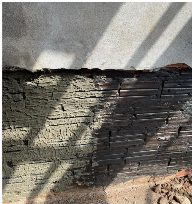
Figura 25 – Chapisco da parede após a impermeabilização
