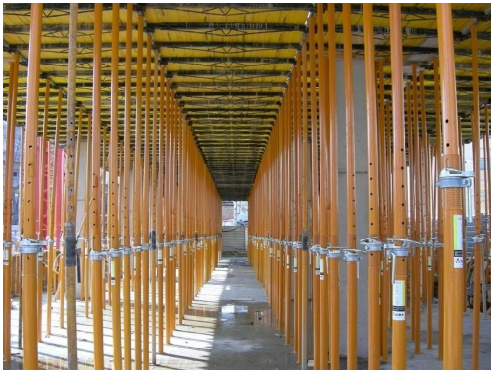
Figura 13 – Escoramento de laje convencional de concreto armado.
