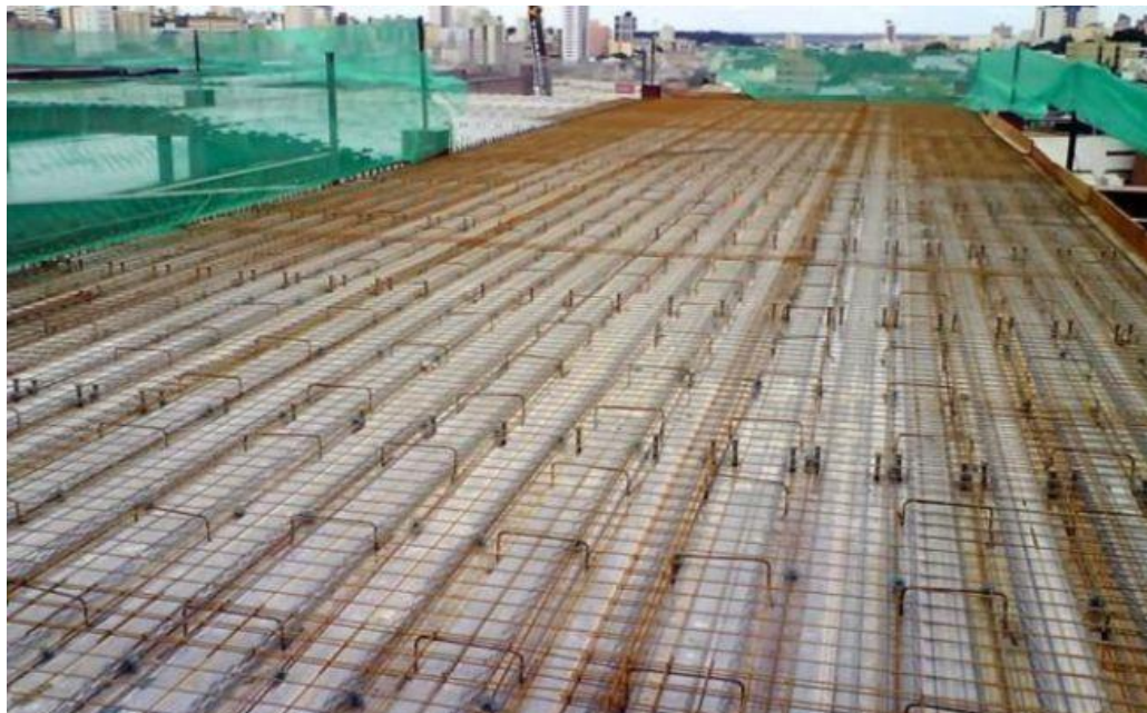
Figura 12 – Detalhe das armaduras em uma laje mista.
