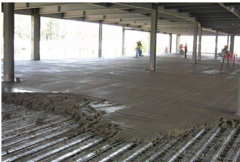
Figura 14 – pavimento inferior a uma laje steel deck .
