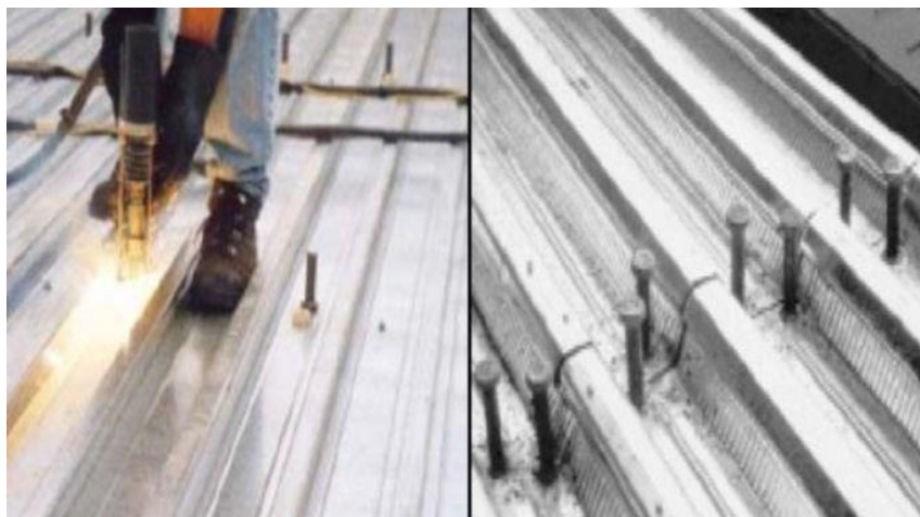
Figura 7 – instalação stud bolt
