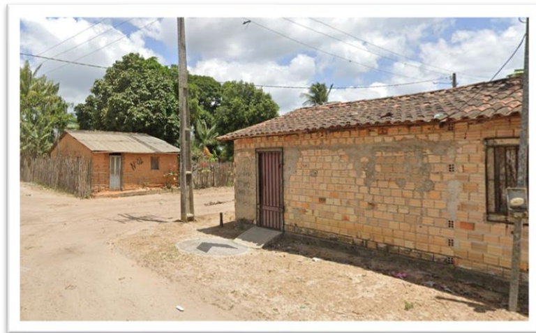
Figura 11: Contraste de materias usadas na construção de casas
