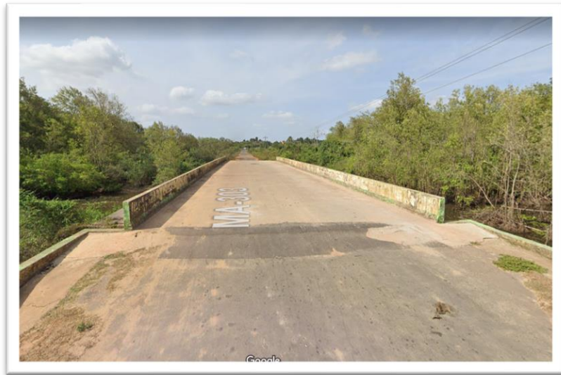
Figura 9: Ponte da divisa entre Serrano e Bacuri (MA)
