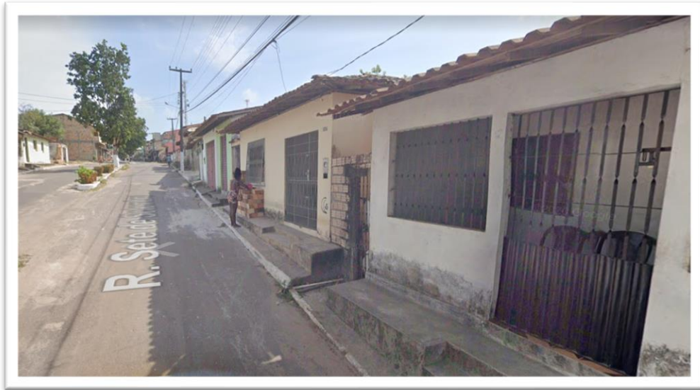
Figura 10: Casas sem afastamento lateral e recuo frontal à avenida
