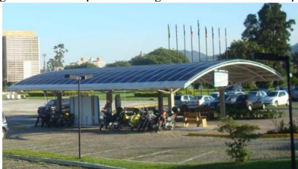
Figura 33: Planta piloto do megawatt solar em Florianópolis
