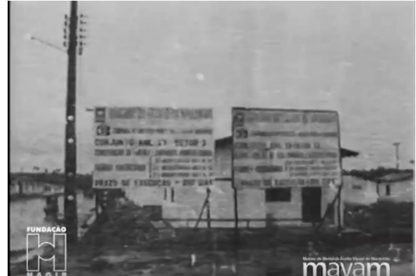
Figura 17 - Placa da obra
