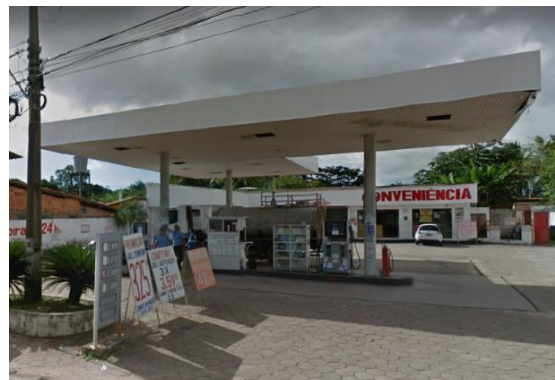
Figura 47 – [8] Posto de Gasolina Itapiracó
