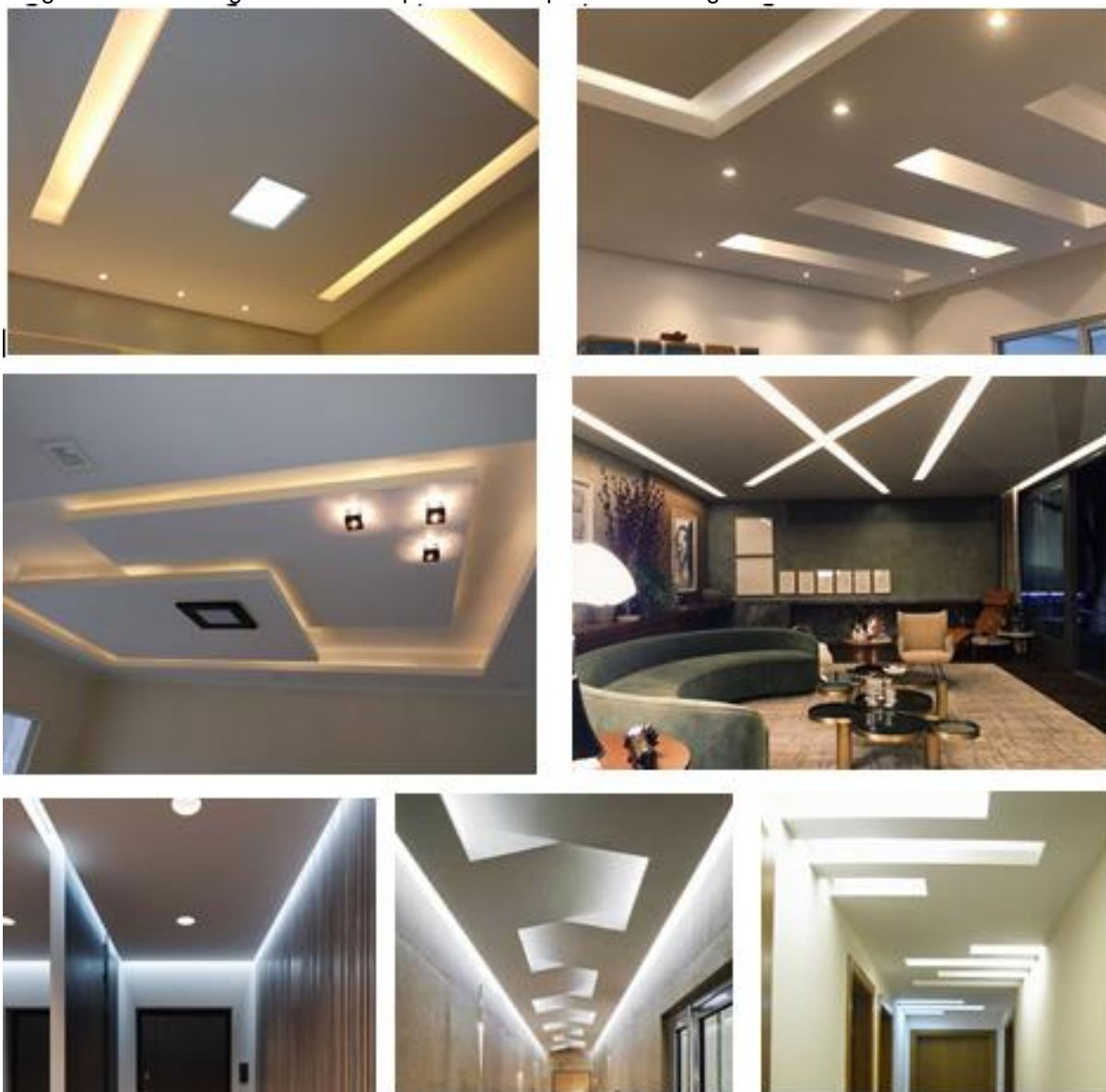
Figura 16 Sete imagens com exemplos de usos para forros de gesso
