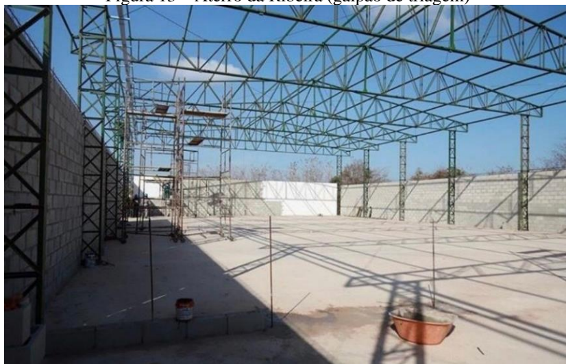
Figura 13 – Aterro da Ribeira (galpão de triagem)
