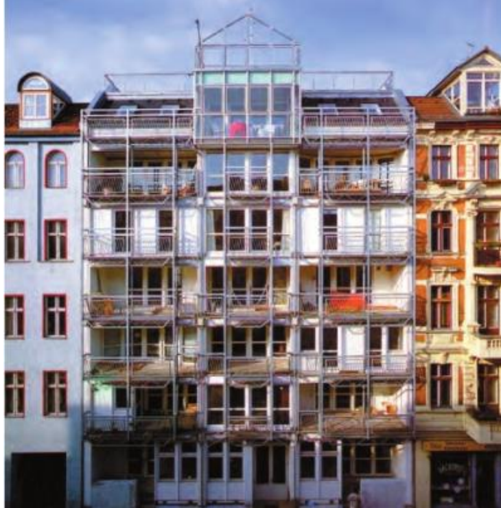
Figura 25 - Obra de habitação social feita com a técnica de reforma Altbau
