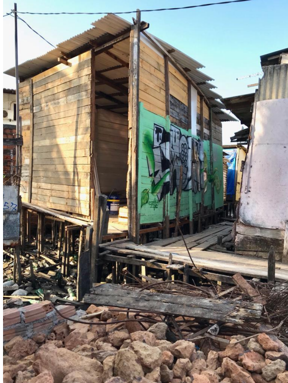
Figura 8 - Estrutura de uma casa em assentamento informal no Maranhão
