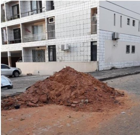
Figura 39: Materiais de Construção em área pública
