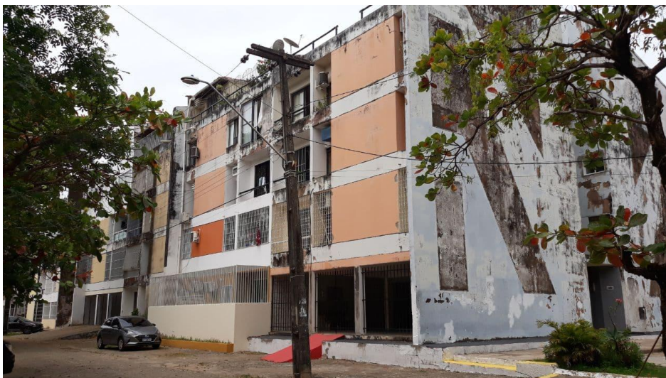
Figura 55: Fachada de edificação do Conjunto Habitacional Barramar
