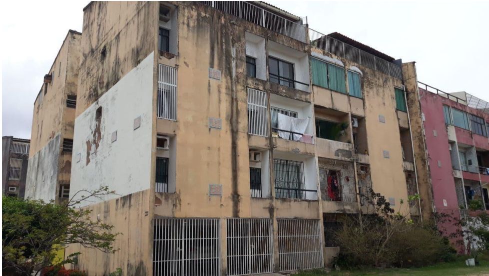
Figura 56: Fachada de edificação do Conjunto Habitacional Barramar
