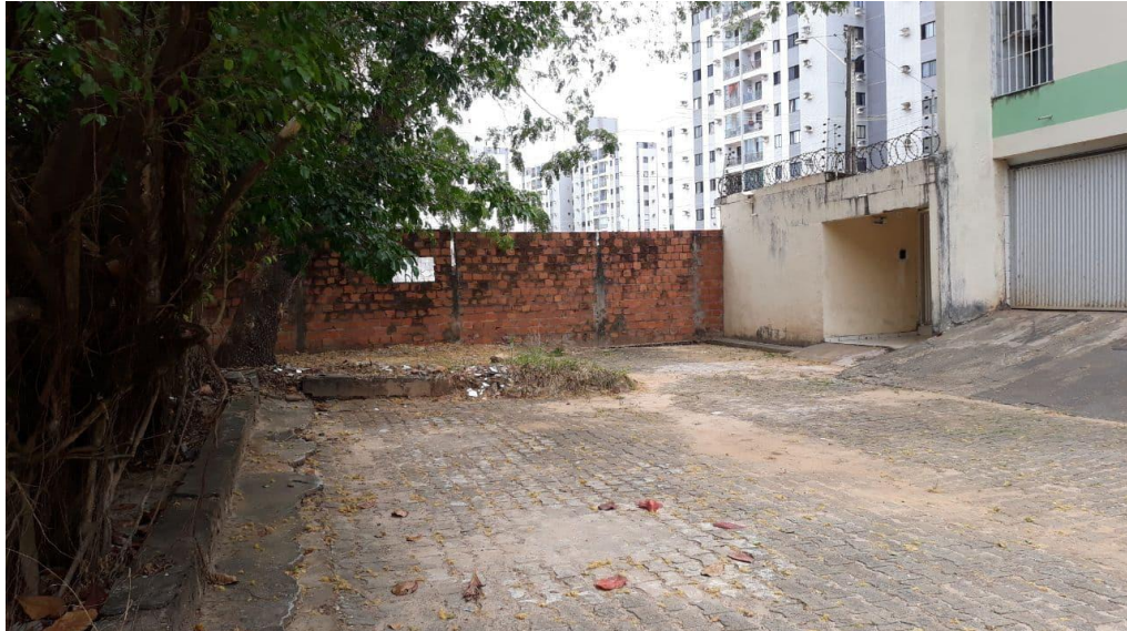
Figura 58: Ruínas do muro construído no local
