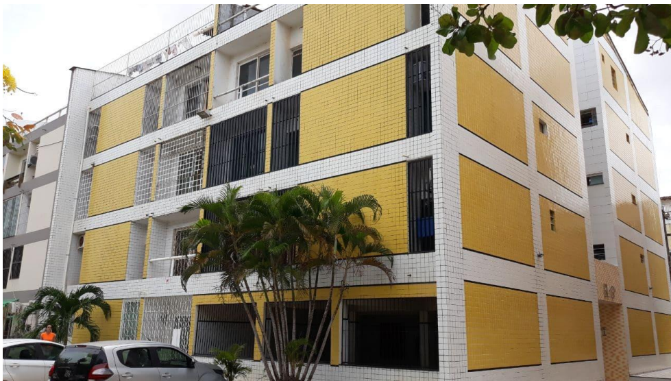
Figura 57: Fachada de edificação do Conjunto Habitacional Barramar
