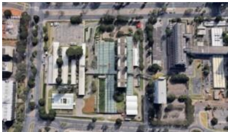
Figura: 08 : vista aérea do hospital sarah kubitschek fonte: google earth
