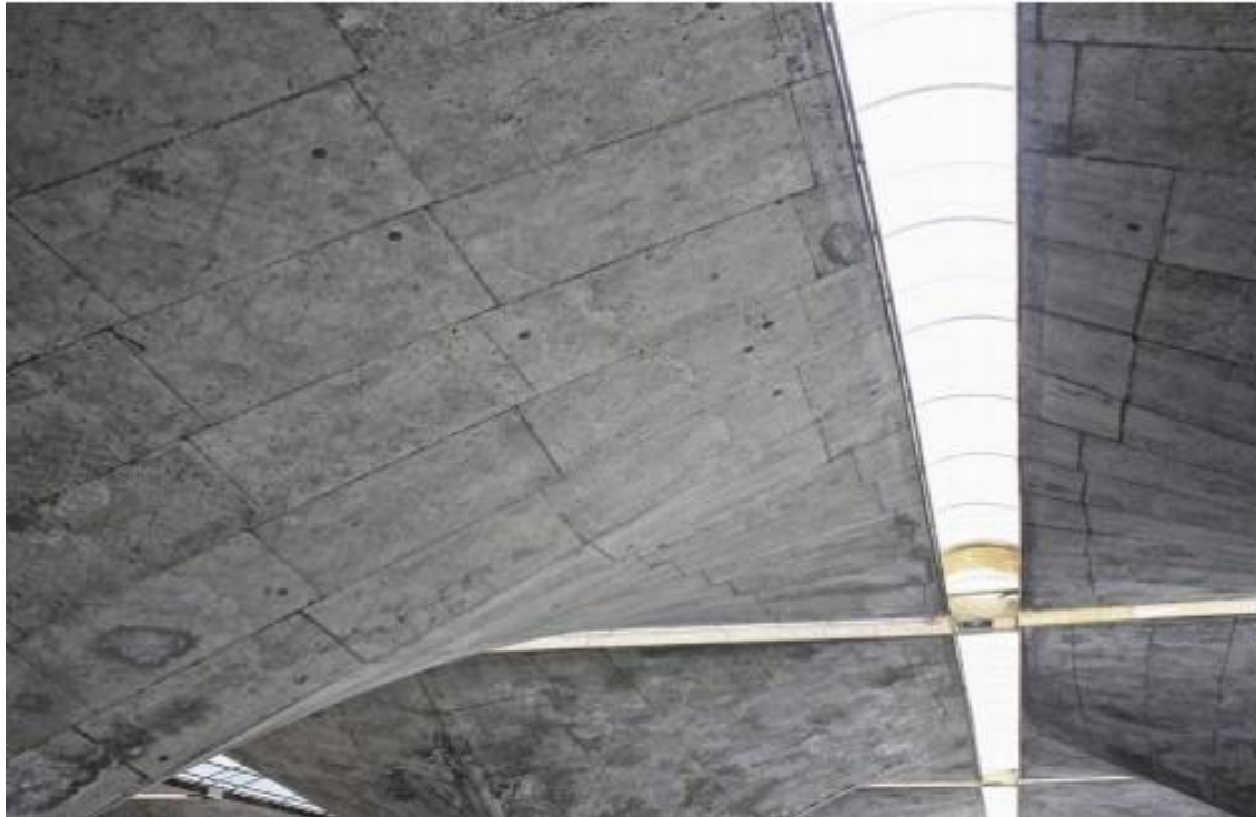
Figura 21: imagem do fechamento zenital do edifício
