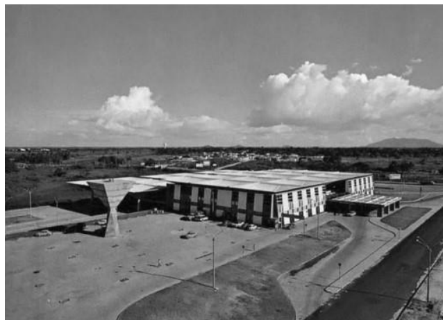
Figura 18 : foto externa - terminal rodoviário engenheiro joão tomé
