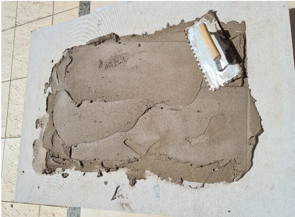
Figura 31: Abertura da Argamassa Colante Industrializadas para Ensaio In Loco
