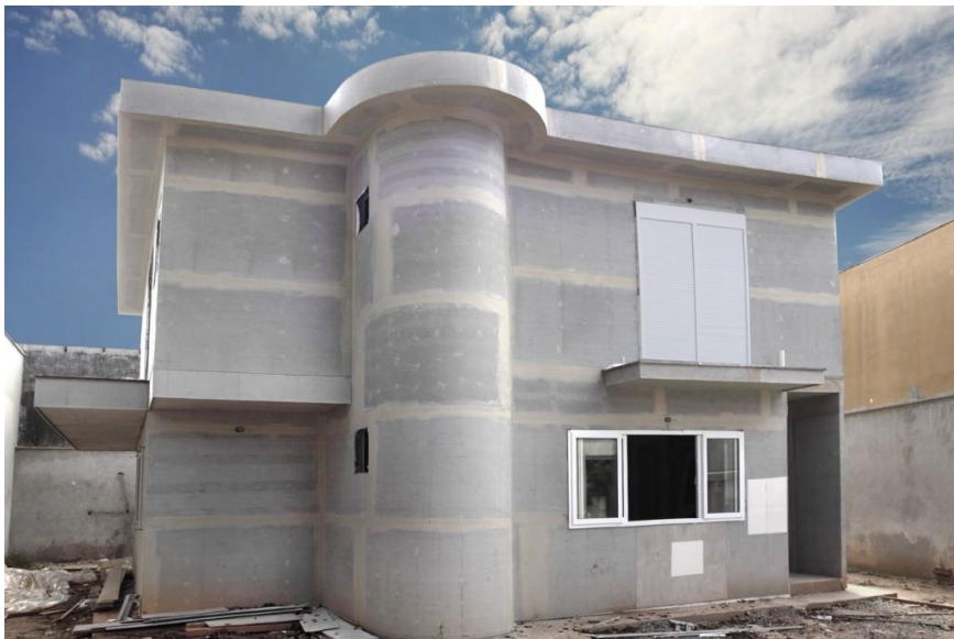
Figura 6: Placa Cimentícia com Ancoragem Invisível
