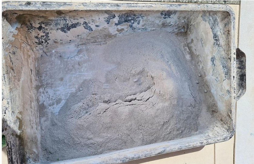
Figura 29: Estocagem de Argamassa Colante para Ensaio In Loco
