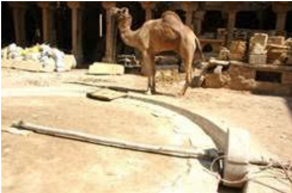
Figura 1: Confeção de Argamassa sob tração animal
