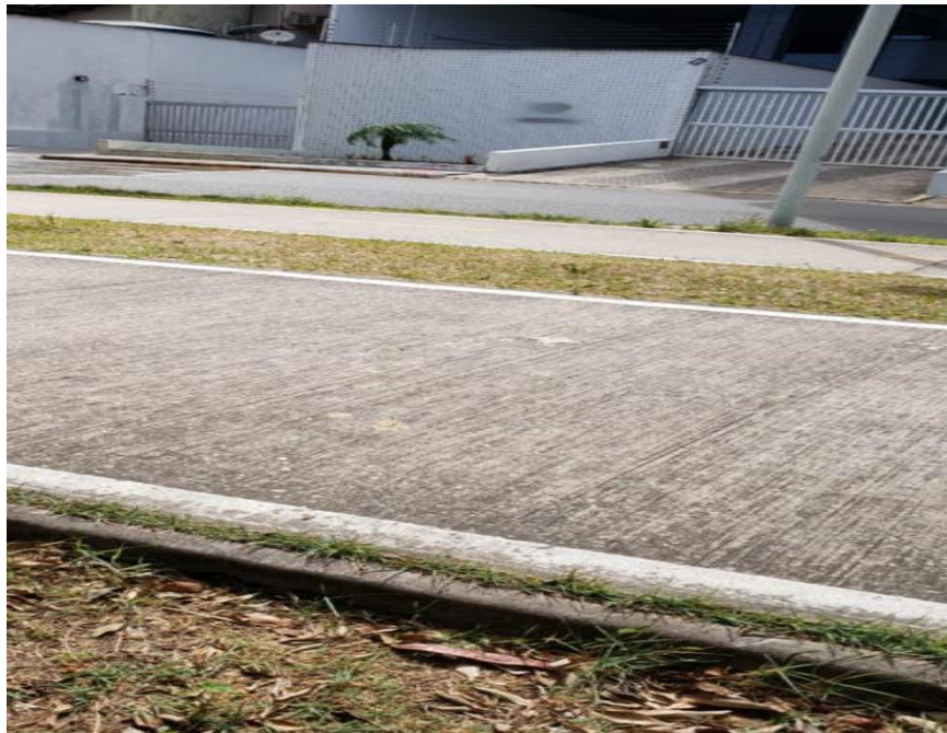
Figura 17 - Condomínio localizado em frente ao ponto PE-10
