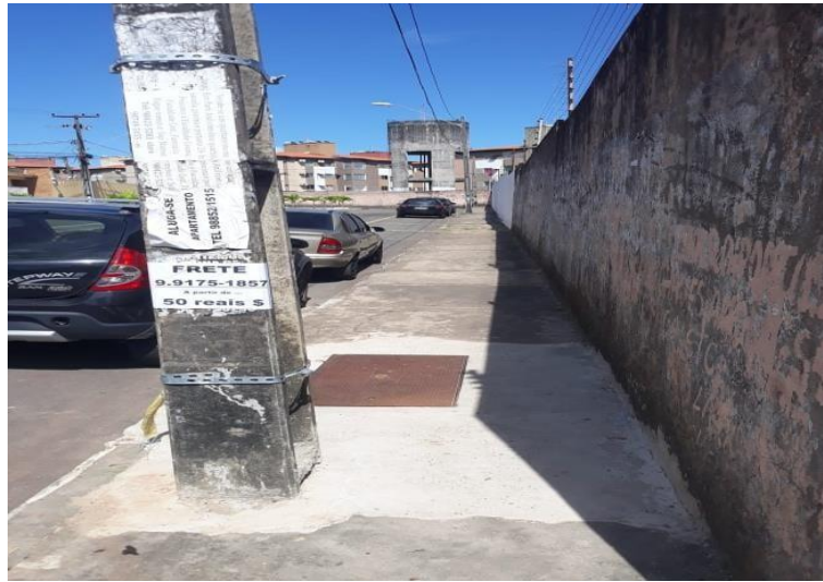
Figura 21 - Rede de Internet Subterrânea e Caixa D'água ao fundo.
