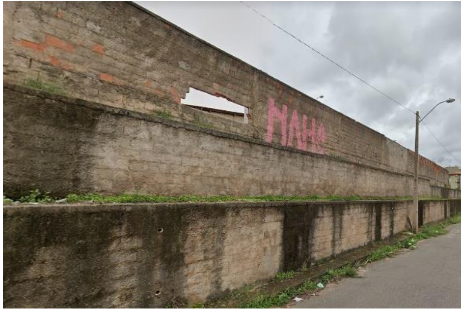
Figura 28 - Acesso entre a Rua Jaguarema e a Rua do Eco Park.
