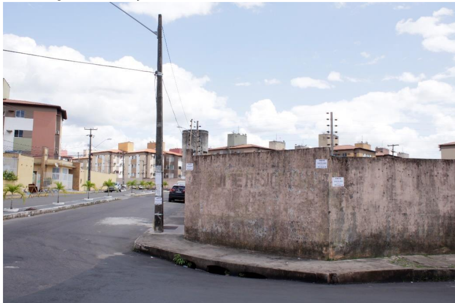
Figura 29 – Calçamento nas vias de acesso aos Condomínios.
