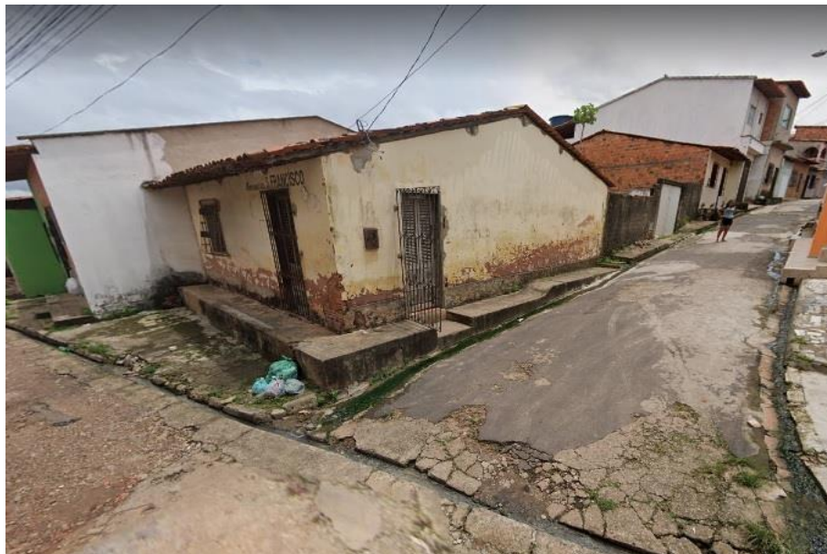
Figura 22 - Esgoto a céu aberto no bairro Pirapora.
