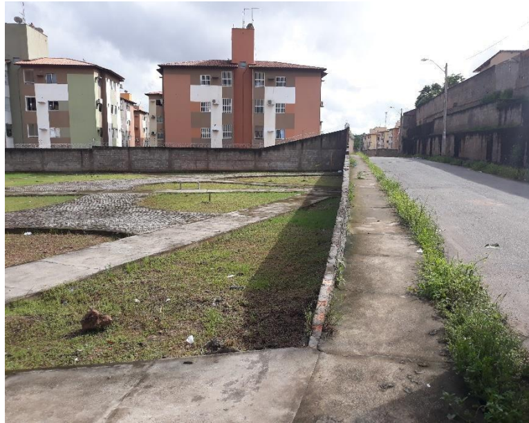
Figura 08 - Separação do bairro Cutim Anil e Pirapora por muro de arrimo. Condomínio Eco Park ao fundo, 2019.
