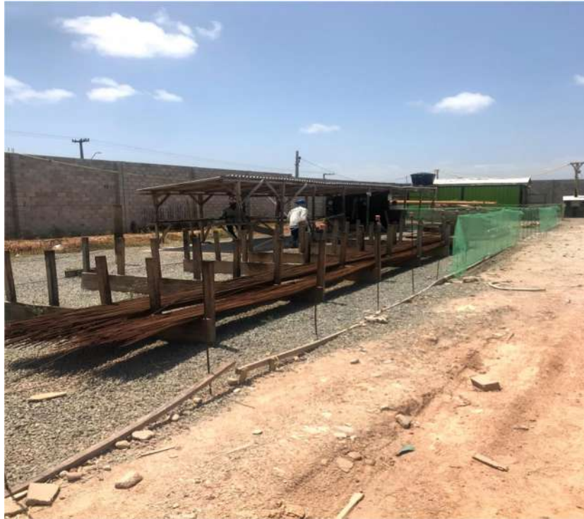
Figura 14 - Área central de armação de ferro do canteiro de obras
