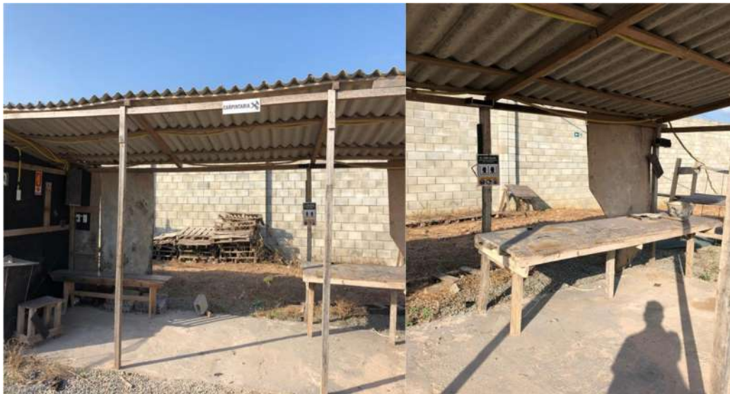
Figura 13 - Área de carpintaria do canteiro de obras
