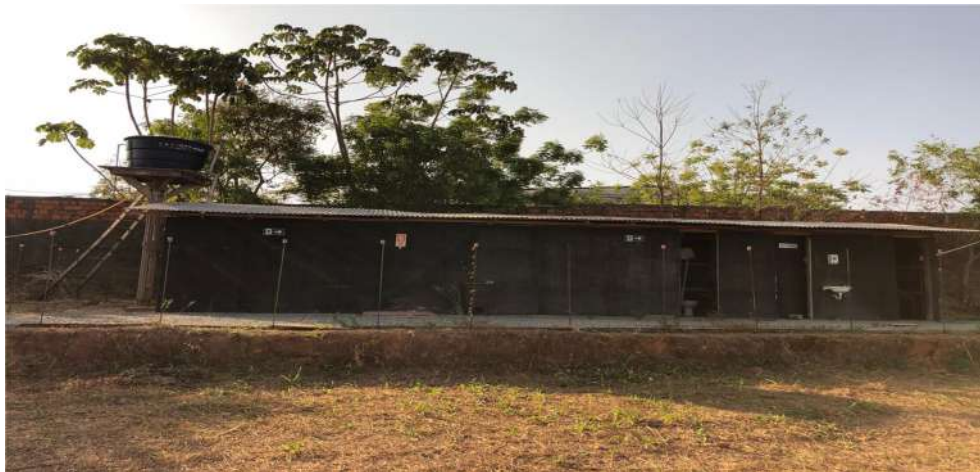
Figura 7 - Vestiário e banheiros
