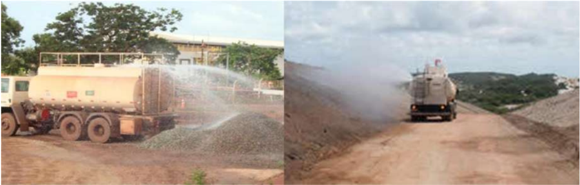
Figura 19 - Aspersão de água sobre camadas expostas e vias de acesso
