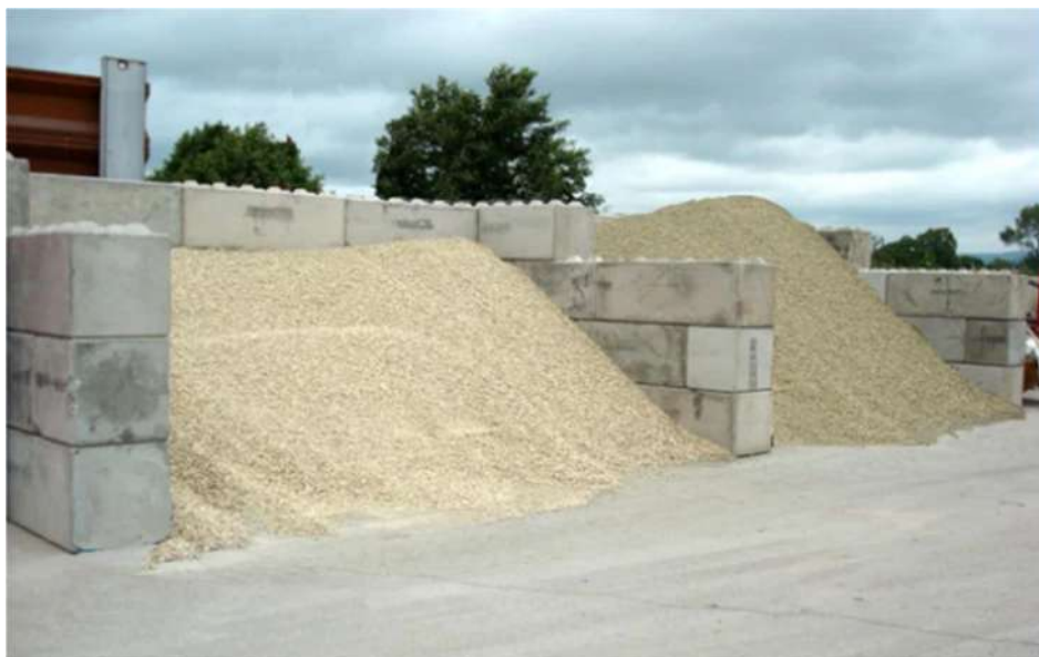
Figura 26 - Contenções laterais em baia de agregados
