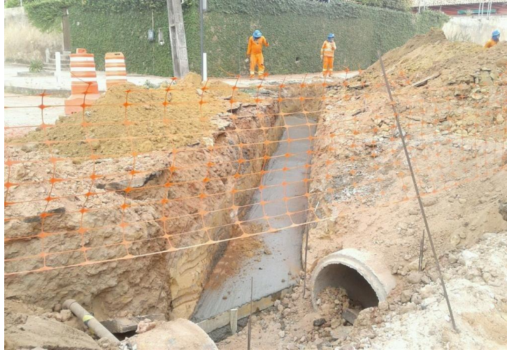
Imagem 5: escavação e execução do berço para as tubulações
