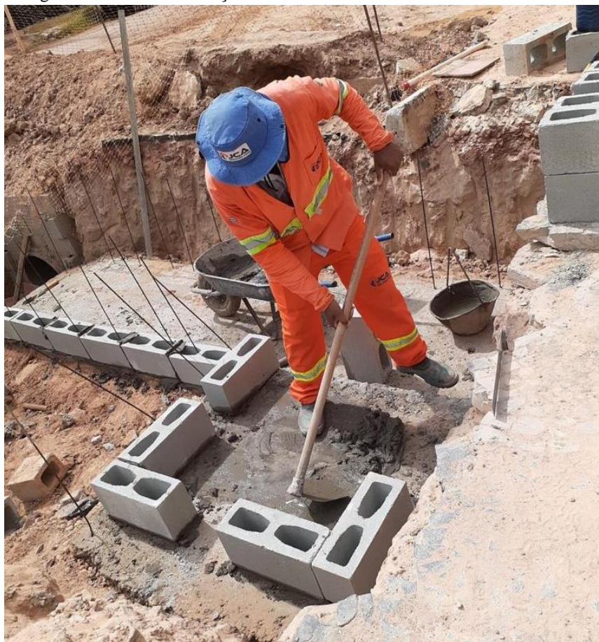
Imagem 11: Início da execução das bocas de lobo
