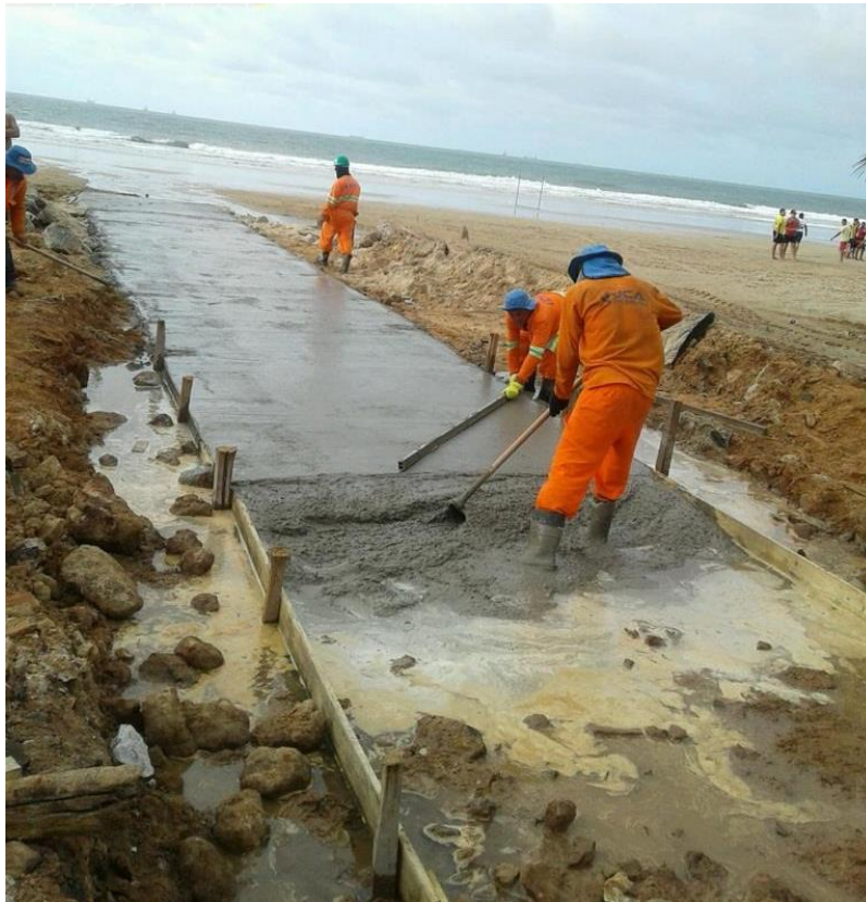
Imagem 15: Execução do contra piso, para assentamento das aduelas
