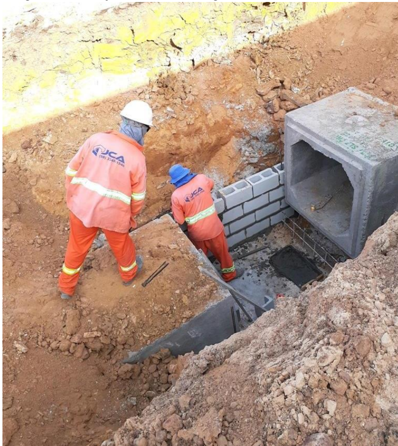
Imagem 10: Execução do método de degraus
