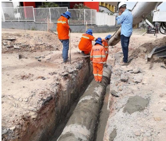
Imagem 6: execução do contra berço das tubulações
