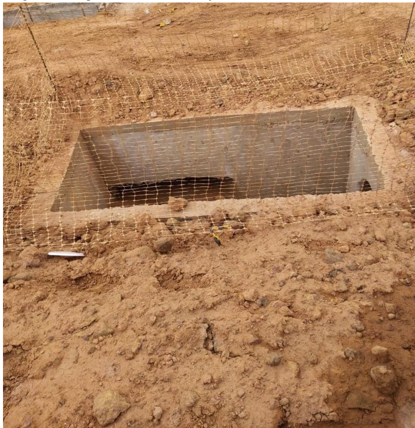
Imagem 14: Etapa de aterro das tubulações e caixas finalizadas
