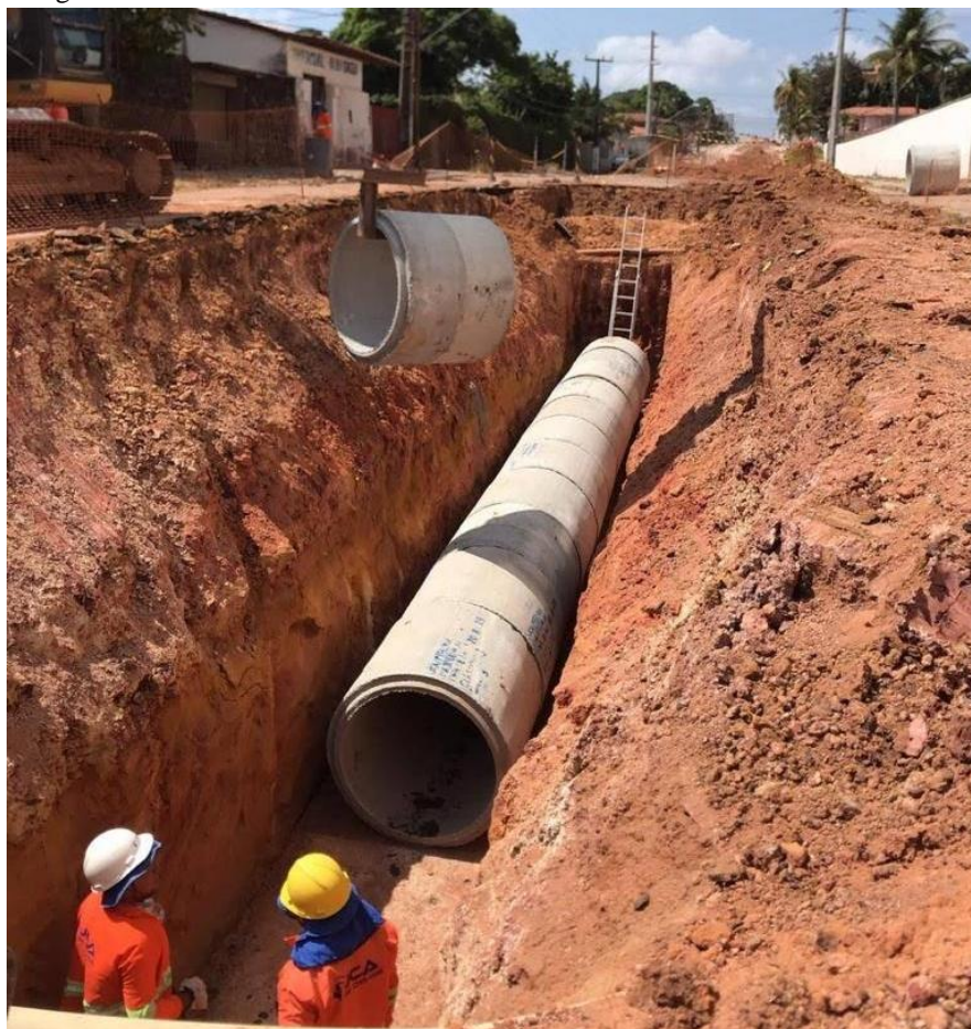
Imagem 9: Assentamento dos tubos de concreto
