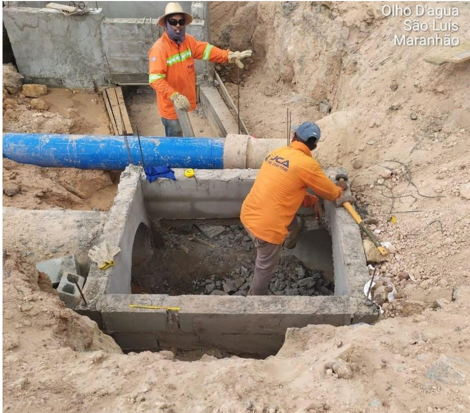
Imagem 13: Execução do canal para contornar a tubulação de abastecimento
