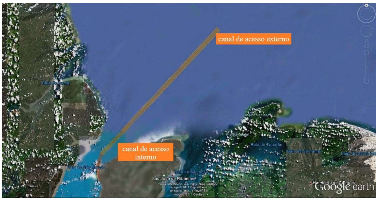
Imagem 2 – Canal de Acesso Interno e Externo
