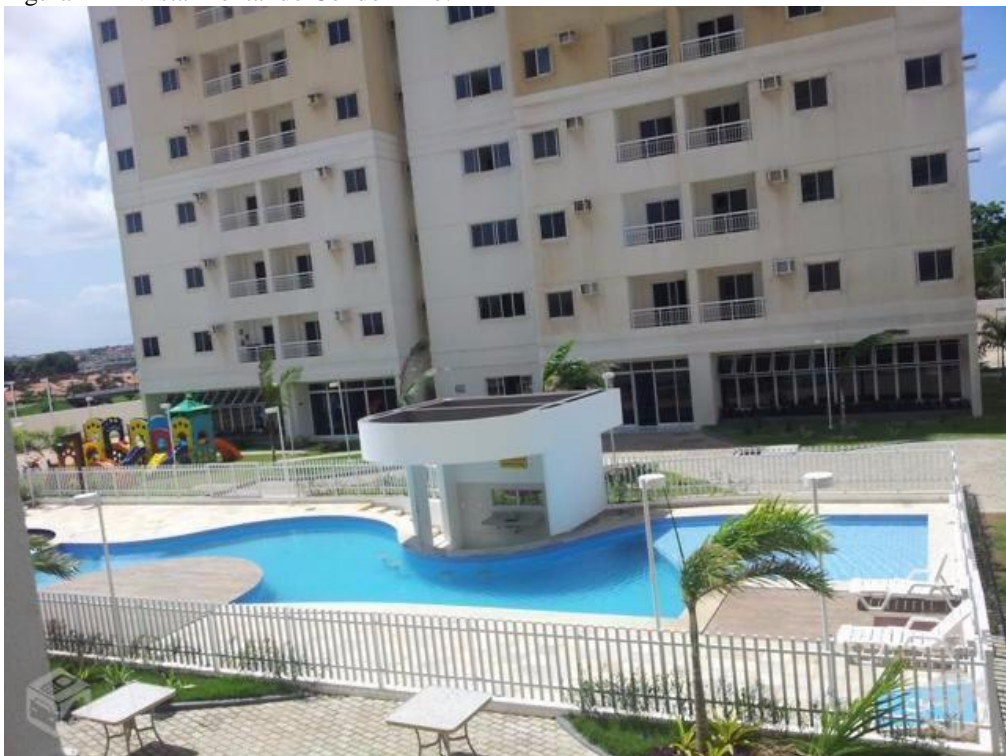
Figura 21 – Vista Frontal do Condomínio.
