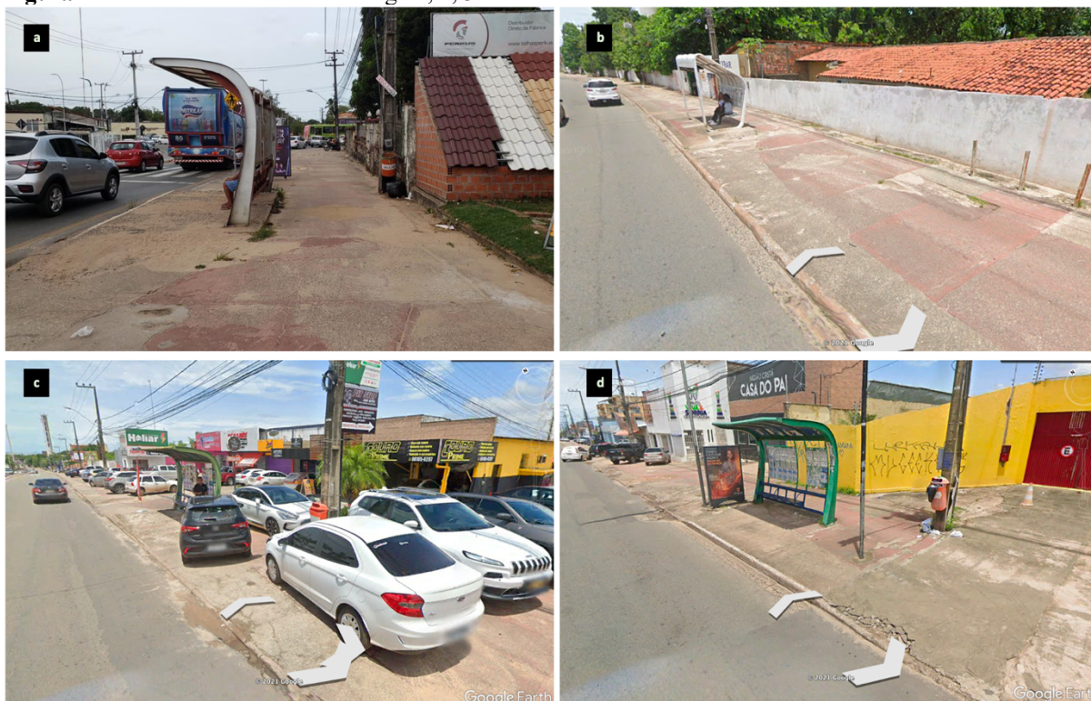
Figura 71 – Parada de ônibus com abrigo 1, 2, 3 e 4.
