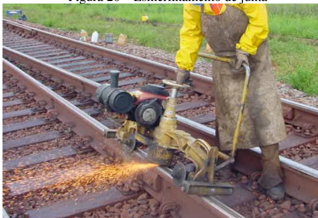
Figura 20 – Esmerilhamento de junta
