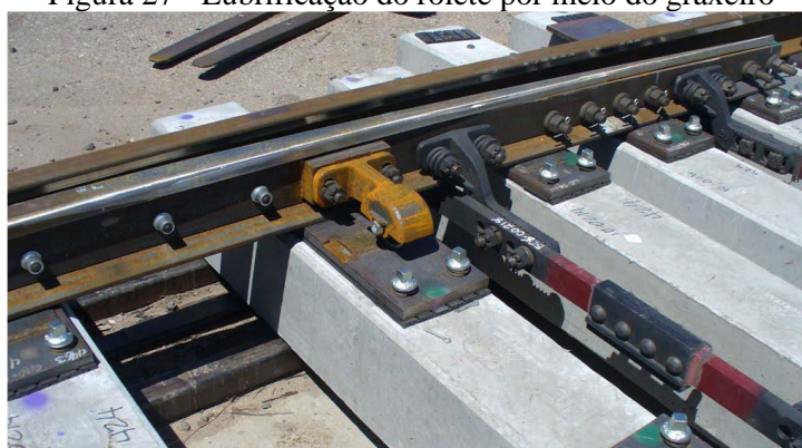
Figura 27 - Lubrificação do rolete por meio do graxeiro
