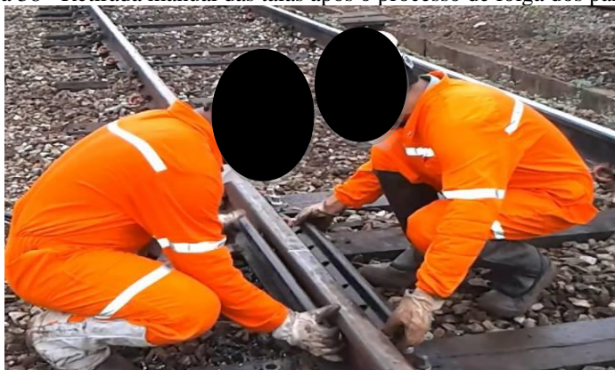
Figura 38 - Retirada manual das talas após o processo de folga dos parafusos
