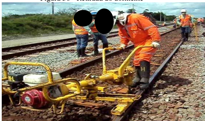
Figura 30 - Retirada do dormente
