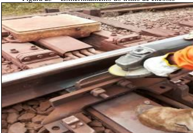
Figura 25 - Esmerilhamento do trilho de encosto
