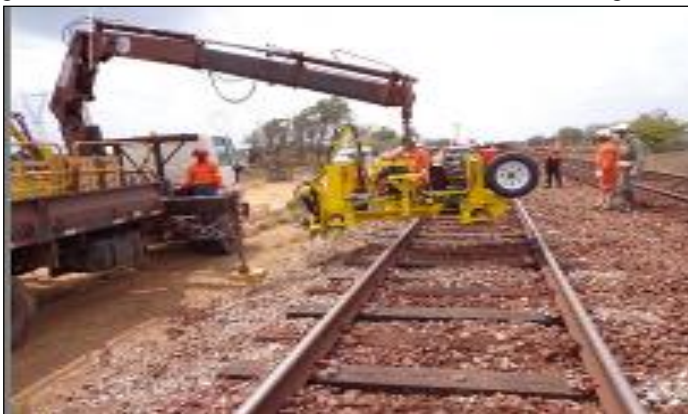
Figura 31 - Posicionamento com auxílio do caminhão com guindauto
