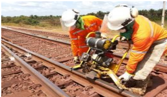
Figura 24 - Trabalhadores iniciando o processo de deslocamento
