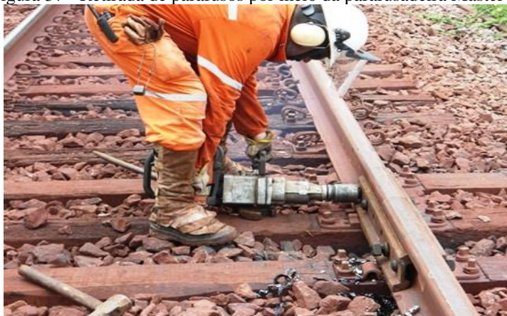
Figura 37 - Retirada de parafusos por meio da parafusadeira Master 35
