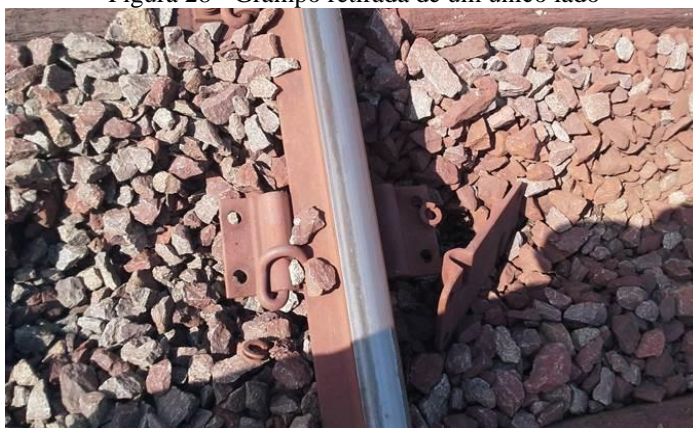
Figura 28 - Grampo retirada de um único lado
