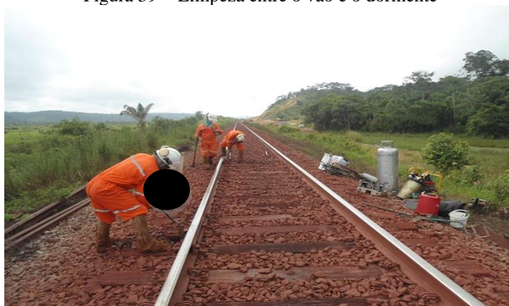
Figura 39 - Limpeza entre o vão e o dormente
