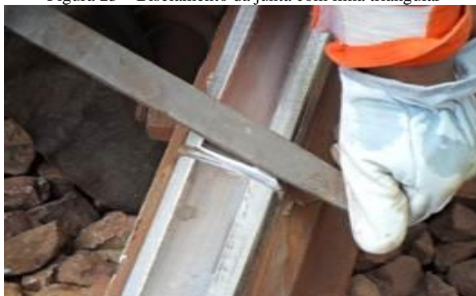
Figura 23 – Biselamento da junta com lima triangular
