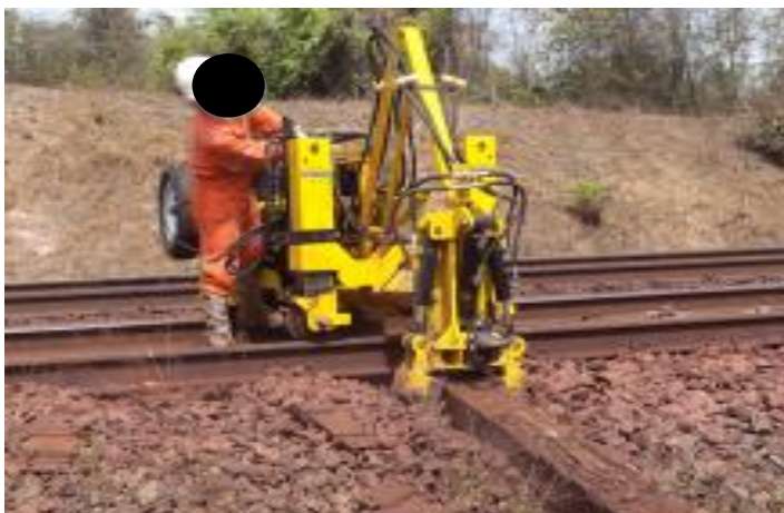
Figura 33 - Retirada de dormente por meio de alavanca
