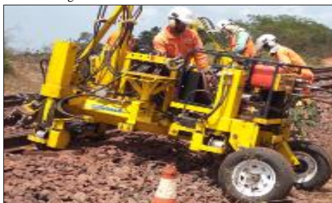
Figura 29 - Posicionamento da trefonadeira
