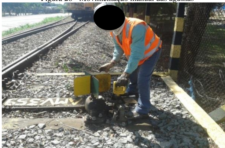
Figura 26 - Movimentação manual das agulhas
