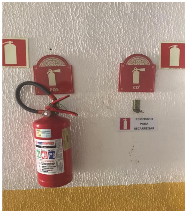
Figura 51 - Pavimento com um extintor (1º andar)
