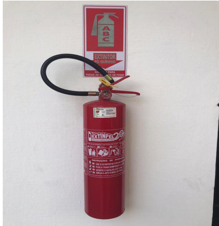
Figura 33 - Extintor Classe A:B:C
