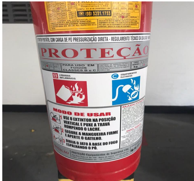
Figura 32 - Extintor Classe B:C
