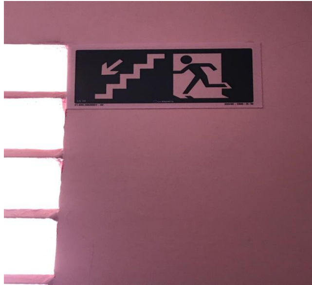
Figura 23 - Sinalização de orientação e salvamento ( descida das escadas )
