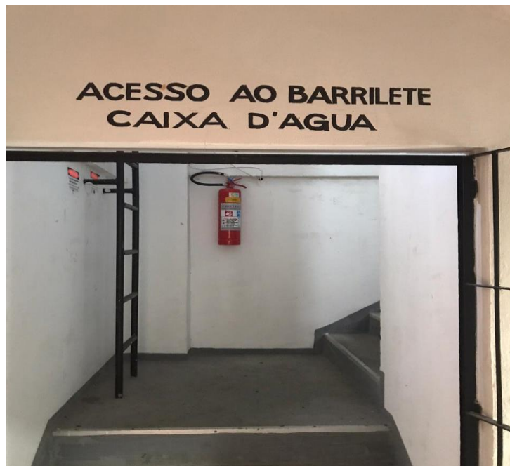
Figura 40 - Sem placa de acesso ao barrilete
