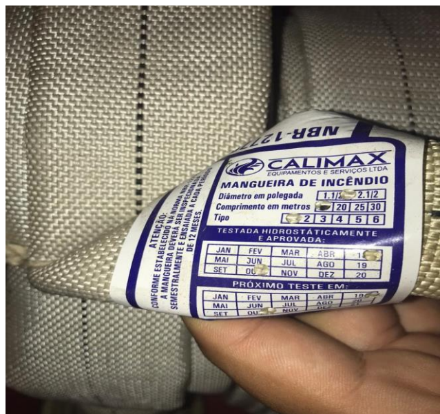
Figura 66 - etiqueta de manutenção da mangueira
