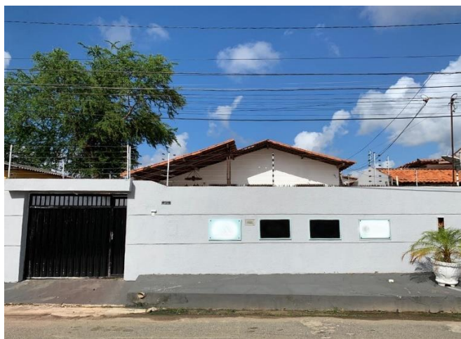
Figura 2 - Detalhe de fachada 2 do imóvel
