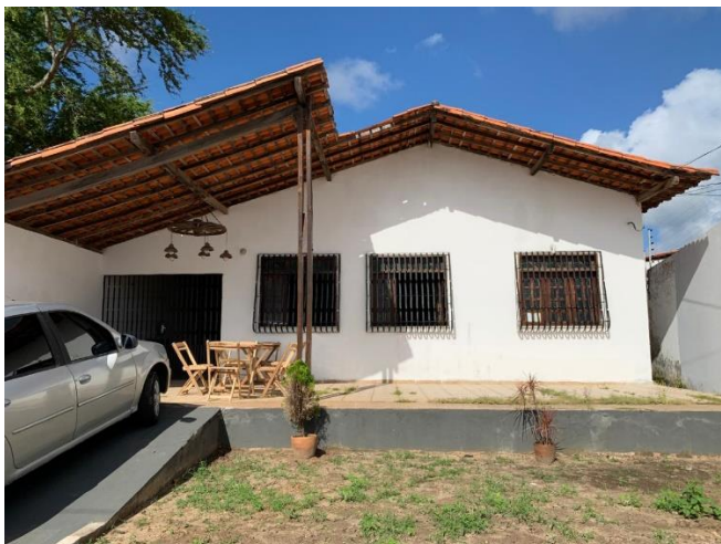
Figura 1 - Detalhe de fachada 1 do imóvel
