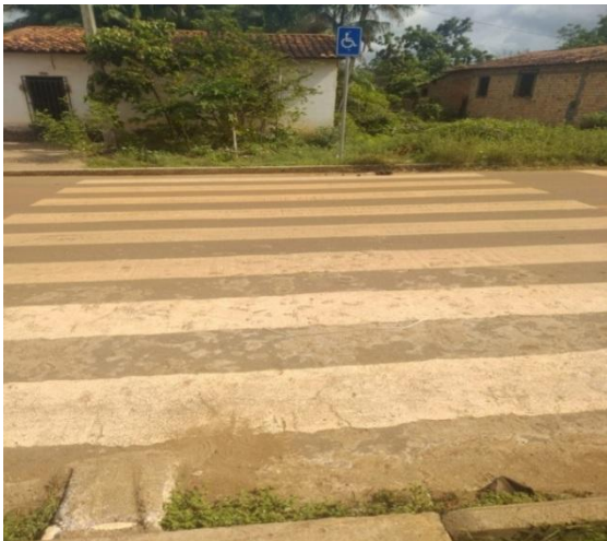
Figura 6 – Faixa de pedestre em frente à escola
