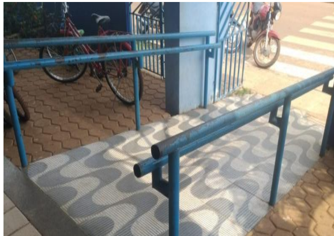
Figura 19 – Corrimão da rampa
