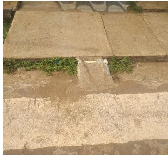
Figura 9 – Rebaixamento da calçada
