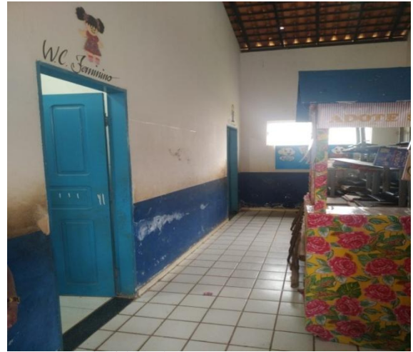
Figura 38 – Corredor de acesso ao sanitários
