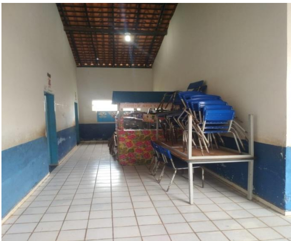
Figura 16 – Piso do corredor
