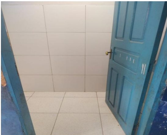
Figura 39 – Porta de acesso ao banheiro
