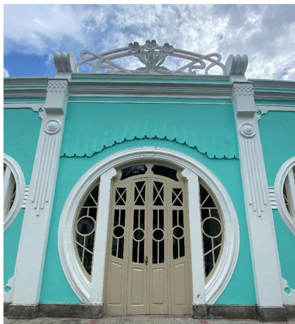
Figura 27: Esquadrias e arabesco na fachada.
