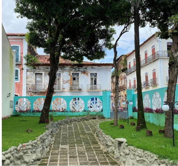
Figura 24: Arcos nos muros da EMEM.
