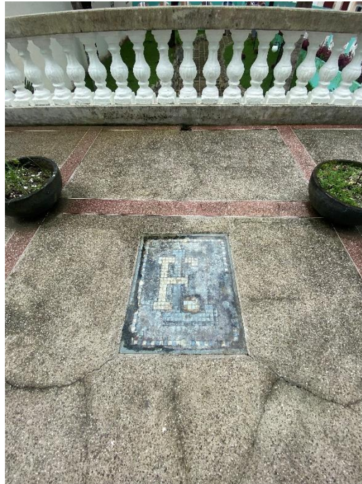
Figura 28: Iniciais no piso.
