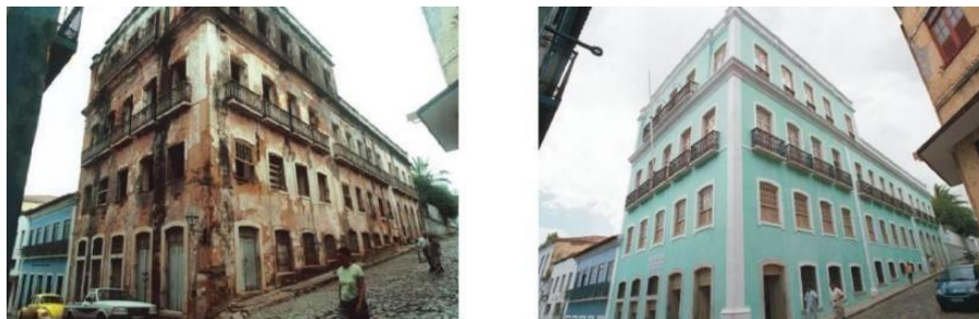
Figura 19: Ruínas transformadas em sede da Escola de Música do Estado do Maranhão.
