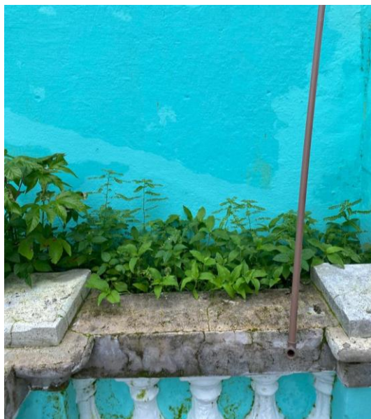
Figura 29: Canteiros da escada.
