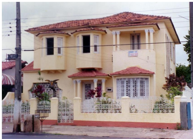
Figura 16: Sede 01 da EMEM localizada na Av. João Pessoa, nº 44, Monte Castelo.
