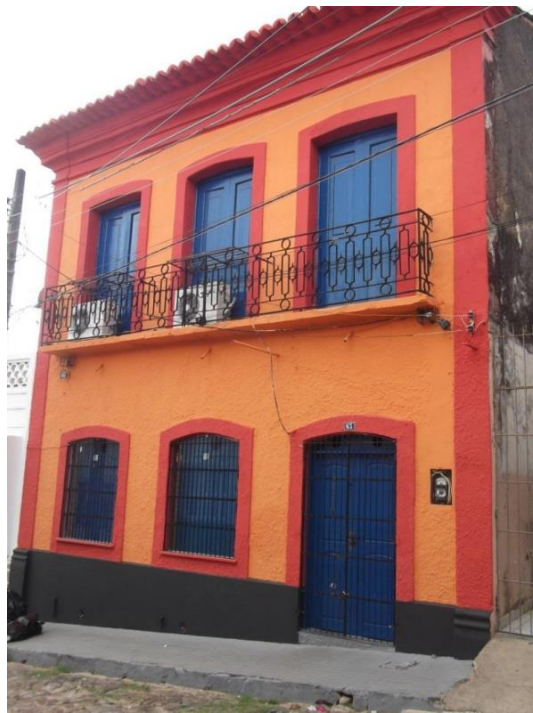
Figura 17: Sede 02 da EMEM localizada na Rua da Saavedra, nº 63, Centro.
