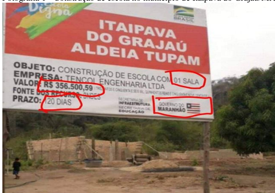
Fotografia 1 - Construção de escola no município de Itaipava do Grajaú/MA.
